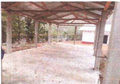
FOTO 5: SUSTITUCION DE PISO TORTA DE COCINA Y REPARACION DE COLUMNAS DE CONCRETO
