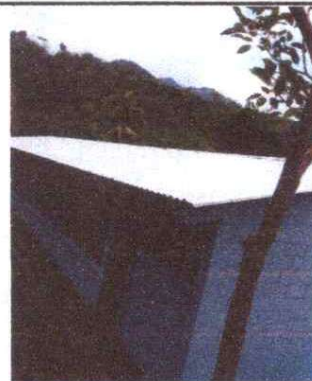
FOTO 4: SUSTITUCION DE LAMINA POR LAMINA TROQUELADA CALIBRE 26
