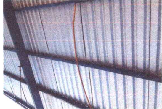
FOTO 2: MANTENIMIENTO A ESTRUCTURA DE METAL
