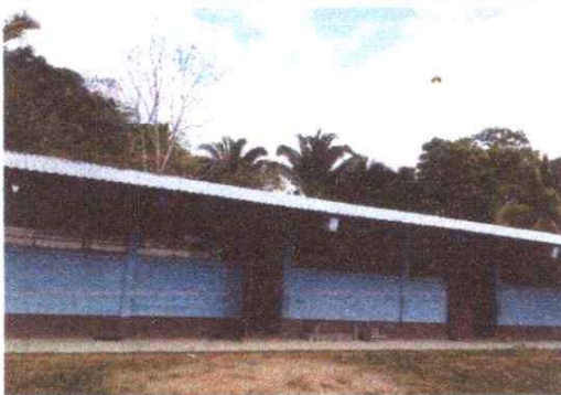
FOTO 3: SUSTITUCION DE LAMINA POR LAMINA TROQUELADA CALIBRE 26
