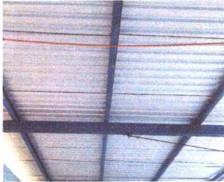
FOTO 1: MANTENIMIENTO A ESTRUCTURA DE METAL
