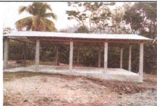
FOTO 6: SUSTITUCION DE PISO TORTA DE COCINA Y REPARACION DE COLUMNAS DE CONCRETO
