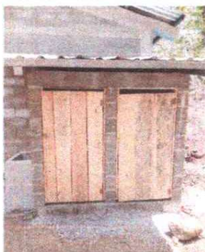
FOTO 9: SUSTITUCION DE SERVICIOS SANITARIOS
