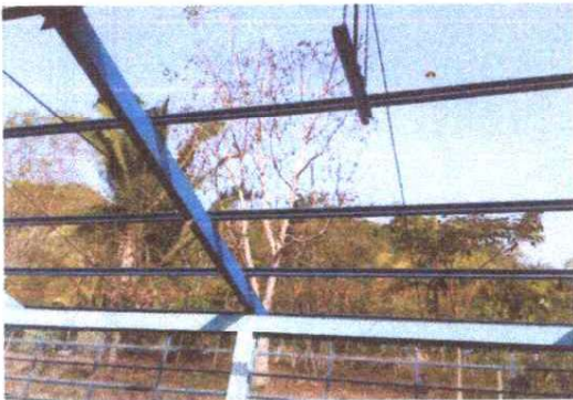
FOTO 3: MANTENIMIENTO A ESTRUCTURA DE METAL
