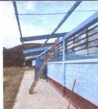
FOTO 2: MANTENIMIENTO A ESTRUCTURA DE METAL
