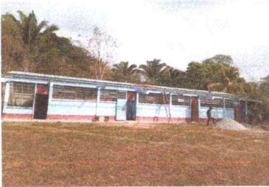
FOTO 1: MANTENIMIENTO ESTRUCTURA DE METAL
