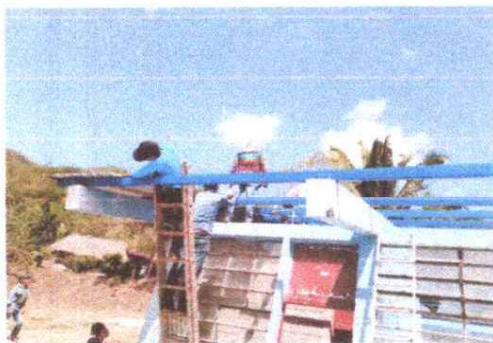
FOTO 5: INSTALACION DE LAMINA TROQUELADA CALIBRE 26
