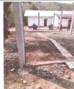
FOTO 6: SUSTITUCION DE PISO TORTA DE COCINA Y REPARACION DE COLUMNAS DE CONCRETO
