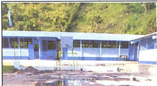
Foto1: SUSTITUCION DE LAMINAS
