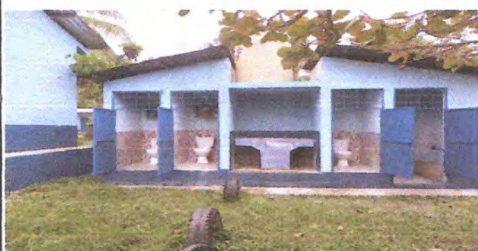
Foto7: sustitucion de inodoro / sustitucion de grifos
