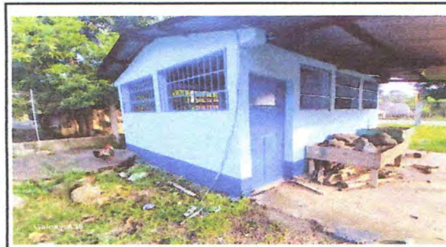
Foto 4: sustitucion de ventanas de madera por metal mas vidrio / sustituciones de balcones de metal.
