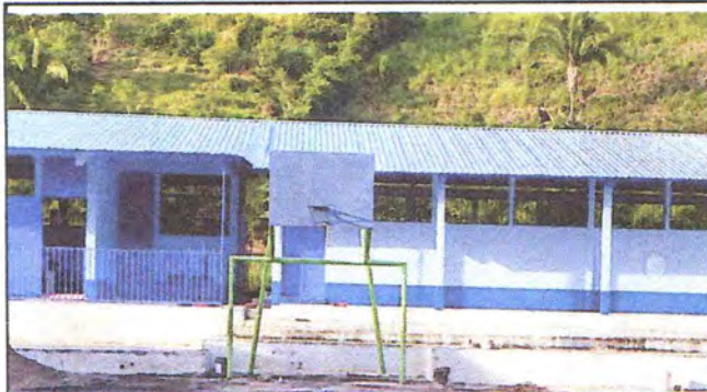
Foto 2: SUSTITUCION DE LAMINAS
