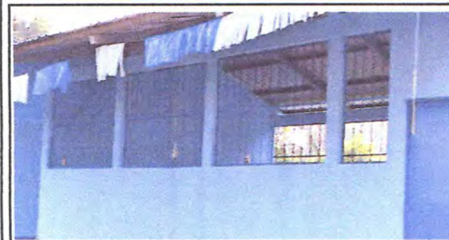
Foto 5: mantenimientos de de balcones de metal
