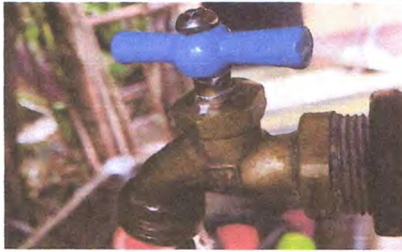
Foto 8: sustitucion de tuveria linea principal / sustitucion de llave de chorro / sustitucion de llave de cheque
