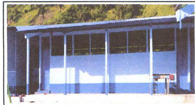
Foto 6: pintura en muros exteriores e interiores.
