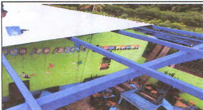
Foto1: SUSTITUCION DE LAMINAS
