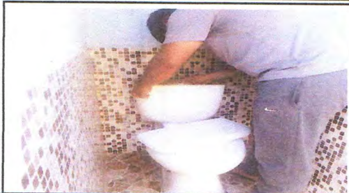
Foto7: sustitucion de inodoro / sustitucion de grifos
