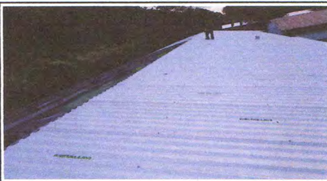
Foto 2: SUSTITUCION DE LAMINAS
