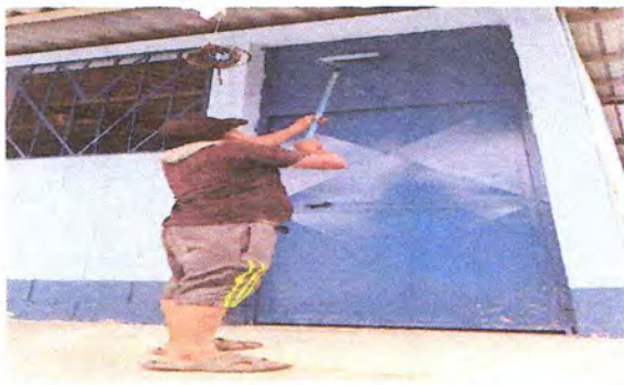
Foto 3: mantenimiento a estructura (lijado, cambio de tuvo, cepillado, sujecciones, aplicación de pintura)
