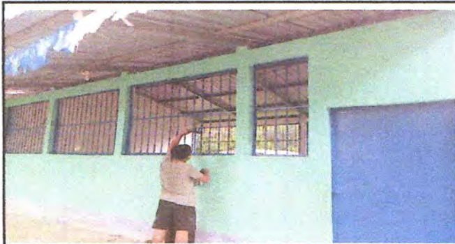
Foto 5: mantenimientos de de balcones de metal
