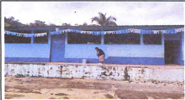
Foto 6: pintura en muros exteriores e interiores.
