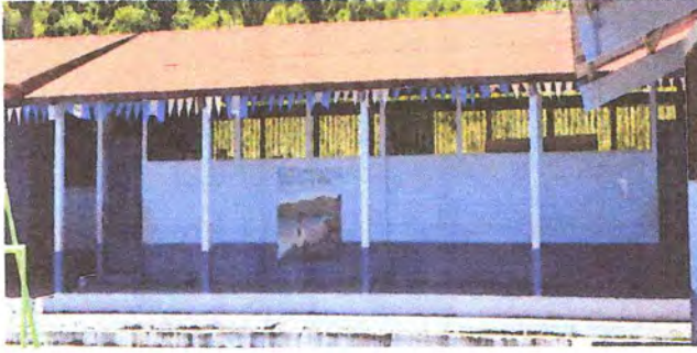
Foto1: SUSTITUCION DE LAMINAS
