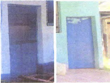
Foto 3: mantenimiento a estructura (lijado, cambio de tuvo, cepillado, sujecciones, aplicación de pintura)
