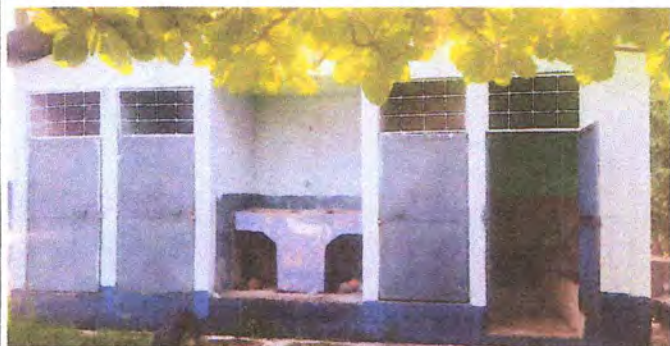
Foto7: sustitucion de inodoro / sustitucion de grifos
