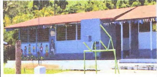
Foto 2: SUSTITUCION DE LAMINAS
