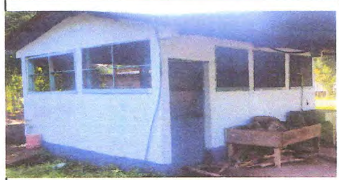
Foto 4: sustitucion de ventanas de madera por metal mas vidrio / sustituciones de balcones de metal.
