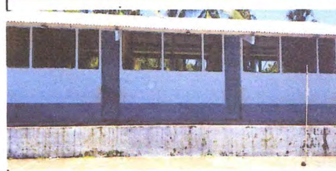
Foto 6: pintura en muros exteriores e interiores.
