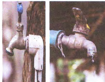
Foto 8: sustitucion de tuveria linea principal / sustitucion de llave de chorro / sustitucion de llave de cheque
