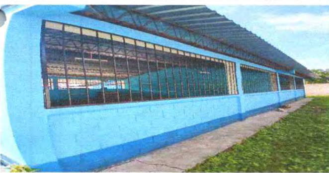
FOTO 5: SUSTITUCIONES DE BALCONES DE METAL
