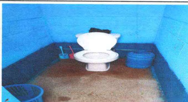
FOTO 16: SUSTITUCION DE ACCESORIOS INODORO
