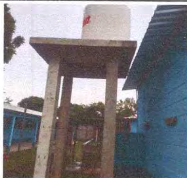
FOTO 13: REPARACION DE BASE DE CONCRETO PARA ROTOPLAS
