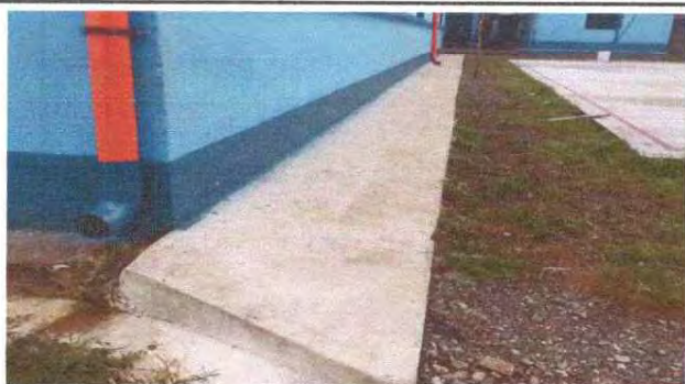
FOTO 11: REPARACION DE BANQUETAS DE CONCRETO ATRÁS
