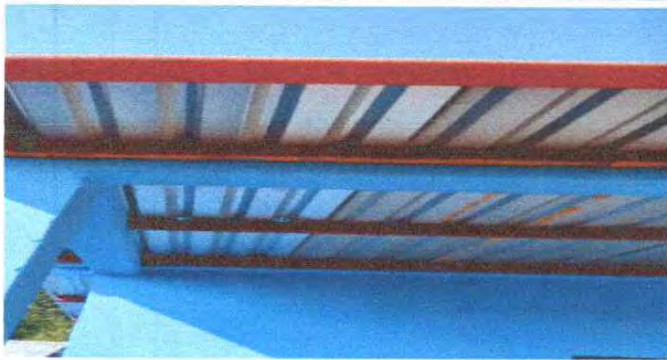
FOTO 1: SUSTITUCIÓN DE LAMINA POR LAMINA TROQUELADA C-26
