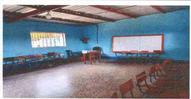
FOTO 6: PINTURAS DE MUROS INTERIOR
