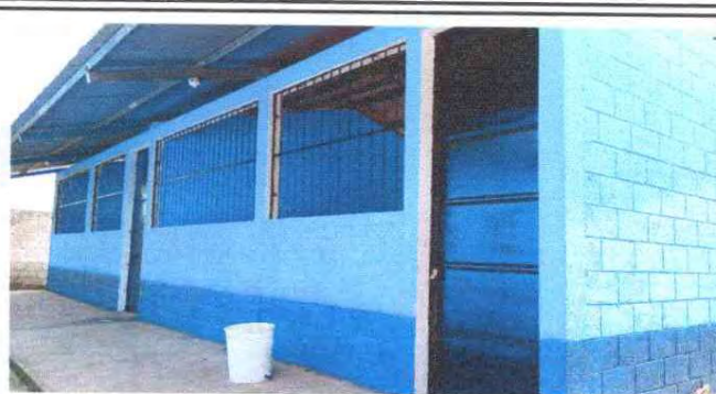
FOTO 8: MANTENIMIENTO DE ESTRUCTURA (LIJADO CAMBIO DE TUBO, CEPILLADO, SUJECIONES, APLICACIÓN DE PINTURA)
