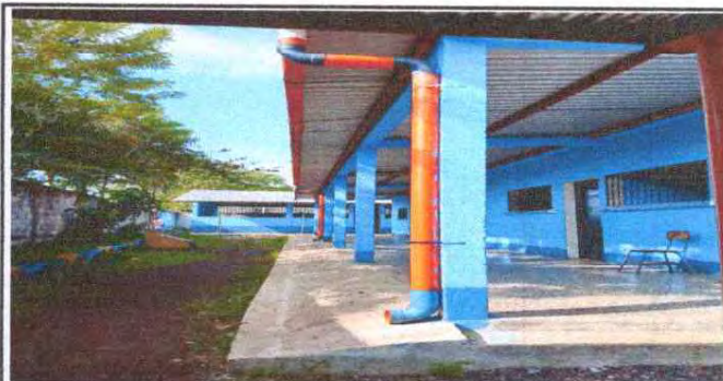
FOTO 12: REPARACION DE BANQUETAS DE CONCRETO
