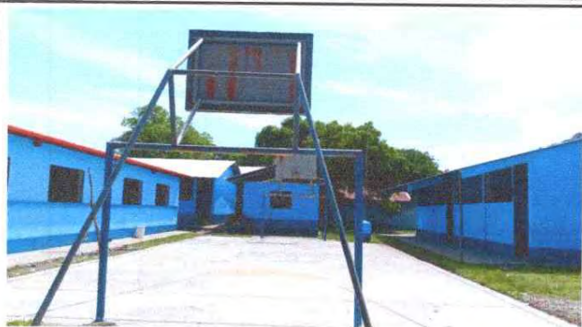
FOTO 7: PINTURAS DE MUROS EXTERIORES E INTERIORES
