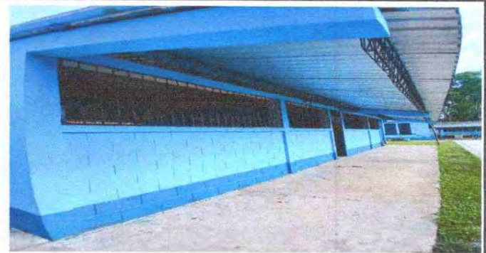
FOTO 4: SUSTITUCIONES DE BALCONES DE METAL
