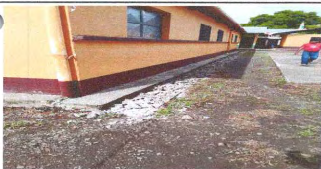
FOTO 11: REPARACIÓN DE BANQUETAS DE CONCRETO
