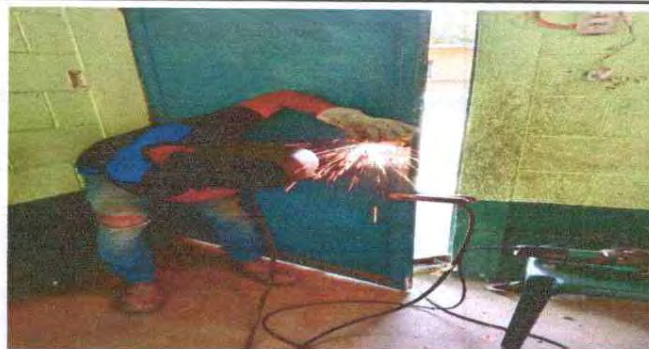
FOTO 8: MANTENIMIENTO DE ESTRUCTURA(LIJADO CAMBIO DE TUBO, CEPILLADO, SUJECCIONES, APLICACIÓN DE PINTURA.
