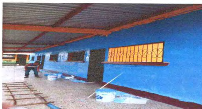
FOTO 7: PINTURA DE MUROS EXTERIORES
