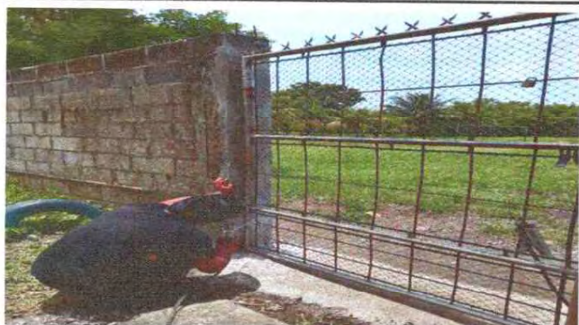
FOTO 3: MANTENIMIENTO DE PORTONES
