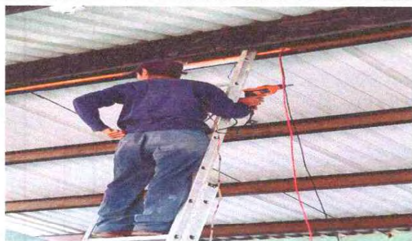
FOTO 9: SUSTITUCION DE DUCTO ELECTRICO MAS ACCESORIOS
