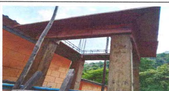
FOTO 12: REPARACIÓN DE BASES DE CONCRETO DE ROTOPLAS
