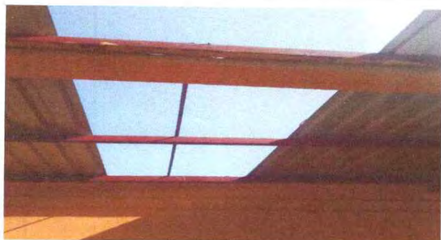
FOTO 1: SUSTITUCIÓN DE LAMINA POR LAMINA TROQUELADA C-26
