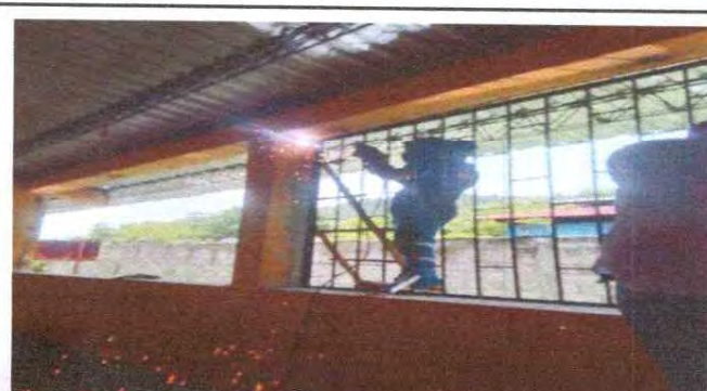
FOTO 4: SUSTITUCIONES DE BALCONES DE METAL
