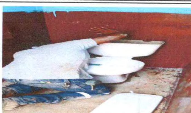
FOTO 14: SUSTITUCIÓN DE ACCESORIOS INODORO
