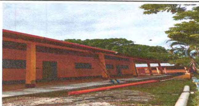
FOTO 13: SUSTITUCIÓN DE TUBERIA LINEA PRINCIPAL DE AGUAS LUVIALES
