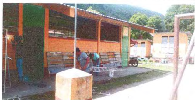
FOTO 5: SUSTITUCIONES DE BALCONES DE METAL
