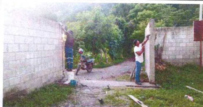
FOTO 2: MANTENIMIENTO DE PORTONES
