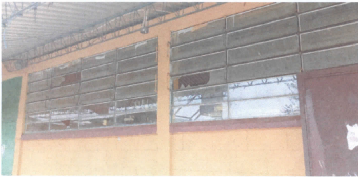
Sustitucion de balcones de metal
