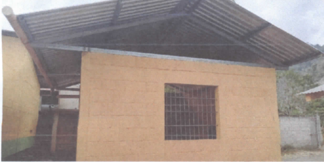
Sustitución de lámina, por láminas troqueladas Aluzin calibre 26
