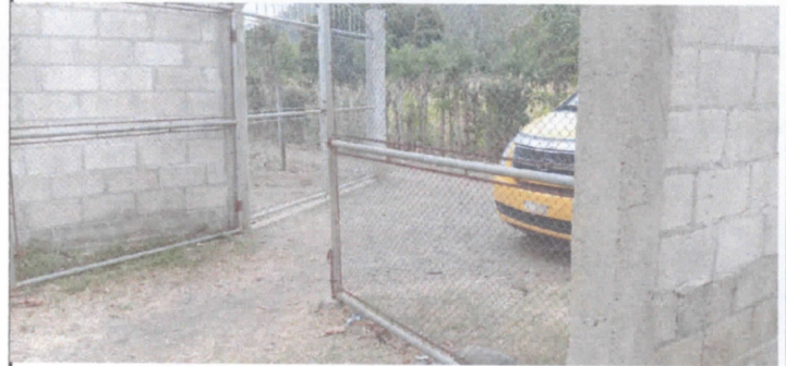
Mantenimiento de portones
