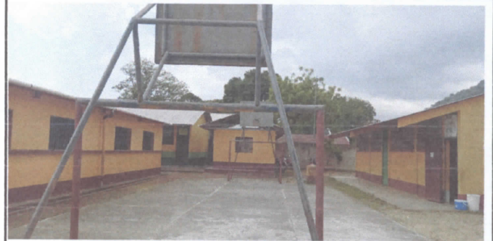
Pintura en muros exteriores e interiores
