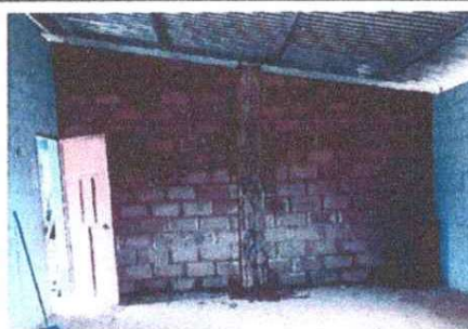
Foto 6: REPARACIÓN DE MURO DE CONTENCIÓN
