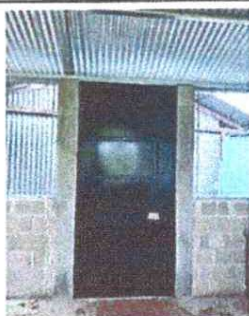
Foto 3: SUSTITUCIÓN DE PUERTA
