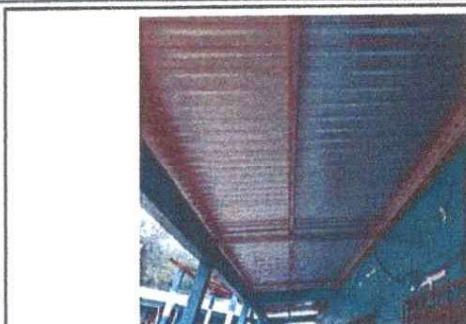
Foto 1: SUSTITUCIÓN DE LÁMINA POR LÁMINA TROQUELADA
