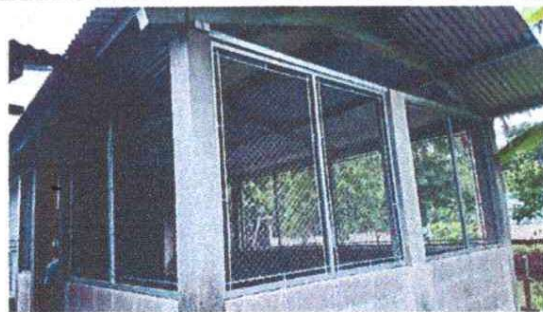
Foto 4: SUSTITUCIÓN DE VENTANAS DE MADERA POR METAL
