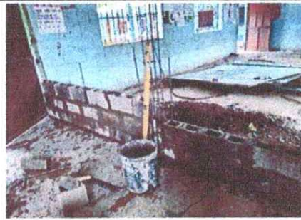
Foto 6: REPARACIÓN DE MURO DE CONTENCIÓN
