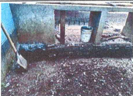
Foto 5: REPARACIÓN DE PISO DE TORTA DE CONCRETO
