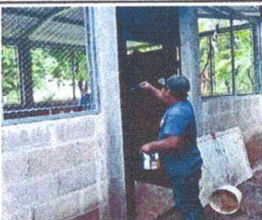
Foto 3: SUSTITUCIÓN DE PUERTA
