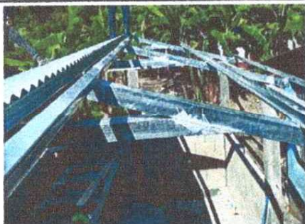
Foto 1: SUSTITUCIÓN DE LÁMINA POR LÁMINA TROQUELADA
