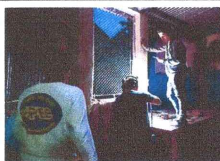
Foto 4: SUSTITUCIÓN DE VENTANAS DE MADERA POR METAL
