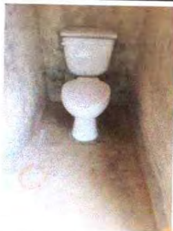
Foto1: SUSTITUCION DE BAÑOS
