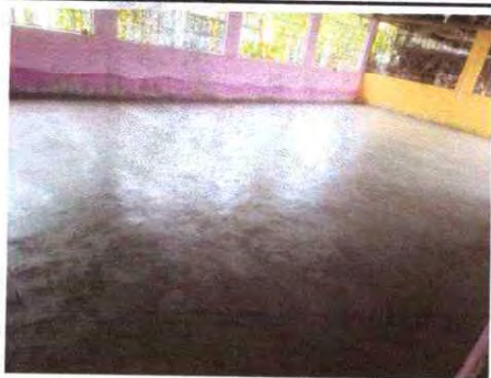
Foto 3: REPARACION DE PISO
