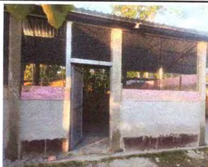
Foto 3: SUSTITUCION DE COLUMNAS DE MADERA POR CONCRETO
