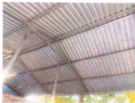
Foto 2: SUSTITUCION DE ESTRUCTURA DE METAL
