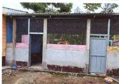
Foto 4: SUSTITUCION DE COLUMNAS DE MADERA POR CONCRETO
