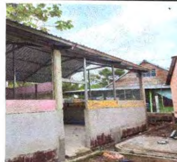
Foto 6: SUSTITUCION DE COLUMNAS DE MADERA POR CONCRETO
