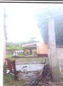
Foto 2: SUSTITUCION DE COLUMNAS DE MADERA POR CONCRETO
