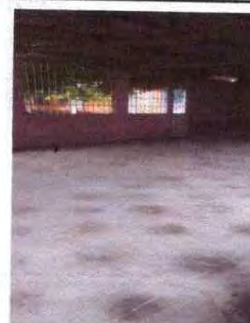
Foto 6: REPARACION DE PISO
