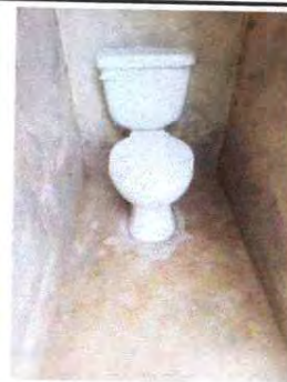
Foto 2: SUSTITUCION DE BAÑOS
