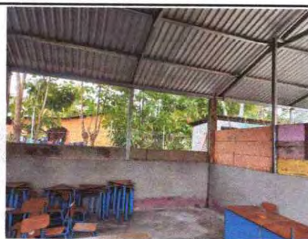
Foto 4: SUSTITUCION DE ESTRUCTURA DE METAL
