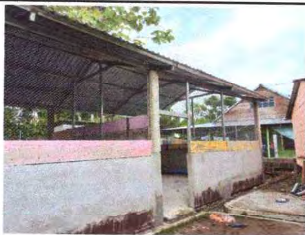
Foto1: SUSTITUCION DE ESTRUCTURA DE METAL
