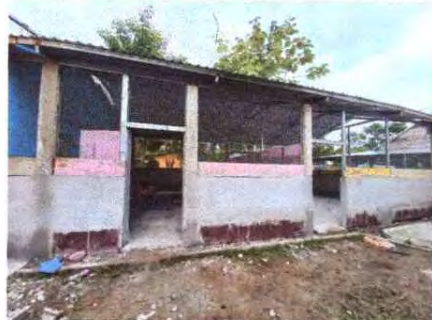
Foto 5: SUSTITUCION DE COLUMNAS DE MADERA POR CONCRETO
