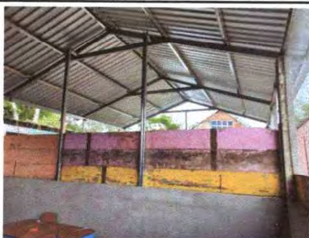
Foto 3: SUSTITUCION DE ESTRUCTURA DE METAL
