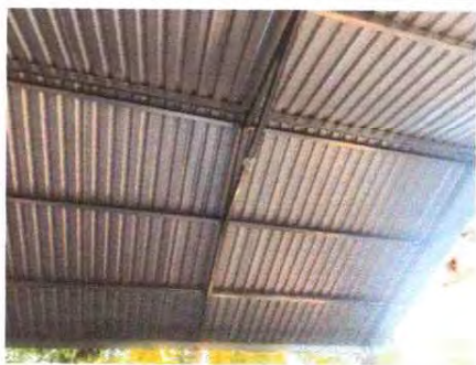
Foto1: SUSTITUCION DE ESTRUCTURA DE METAL
