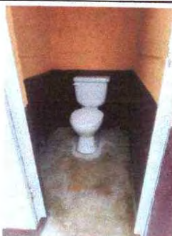
Foto 5: SUSTITUCION DE BAÑOS
