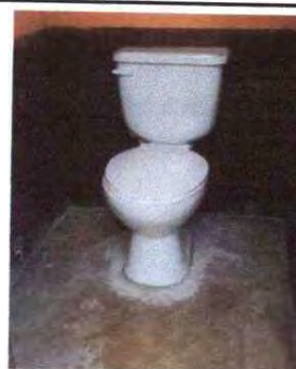
Foto 4: SUSTITUCION DE BAÑOS
