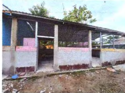
Foto 6: SUSTITUCION DE ESTRUCTURA DE METAL
