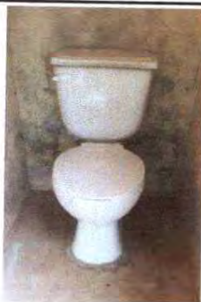
Foto 3: SUSTITUCION DE BAÑOS
