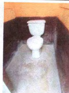
Foto 6: SUSTITUCION DE BAÑOS
