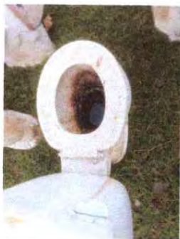
Foto 1: SUSTITUCION DE SANITARIOS
