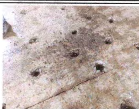
Foto 2: REPARACION DE PISO
