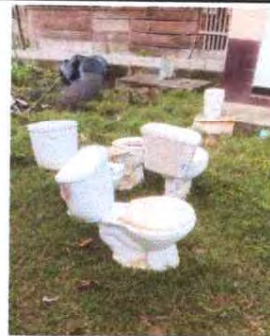
Foto 2: SUSTITUCION DE SANITARIOS
