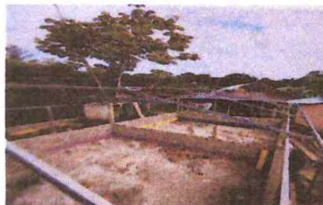
Foto 2: SUSTITUCION DE ESTRUCTURA DE METAL
