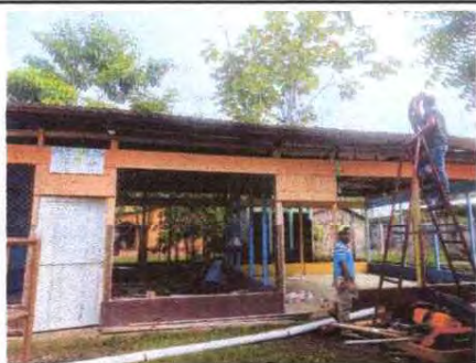
Foto 5: SUSTITUCION DE ESTRUCTURA DE METAL
