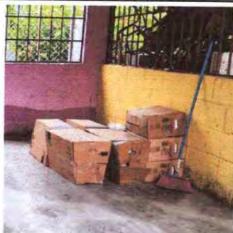
Foto 3: SUSTITUCION DE SANITARIOS
