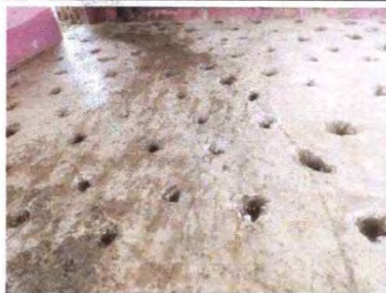
Foto 3: REPARACION DE PISO
