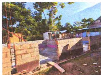
Foto 5: SUSTITUCION DE COLUMNA DE MADERA POR CONCRETO
