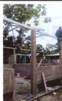
Foto 6: SUSTITUCION DE ESTRUCTURA DE METAL
