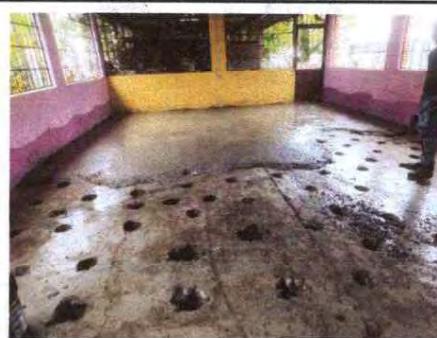
Foto 4: REPARACION DE PISO
