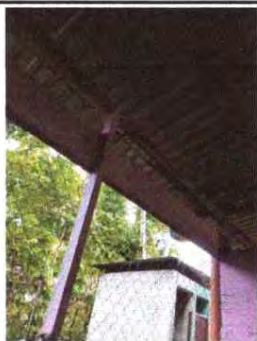
Foto1: SUSTITUCION DE ESTRUCTURA DE METAL
