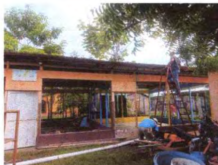
Foto 4: SUSTITUCION DE ESTRUCTURA DE METAL
