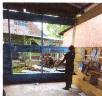
Foto 2: SUSTITUCION DE ESTRUCTURA DE METAL
