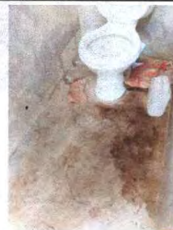
Foto 6: SUSTITUCION DE SANITARIOS
