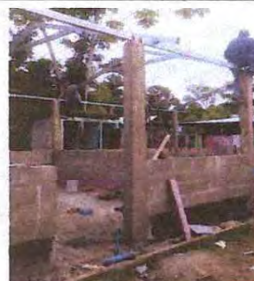
Foto 6: SUSTITUCION DE COLUMNA DE MADERA POR CONCRETO
