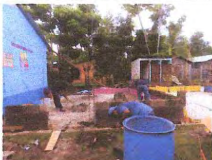
Foto 3: SUSTITUCION DE COLUMNA DE MADERA POR CONCRETO
