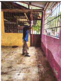
Foto 1: REPARACION DE PISO
