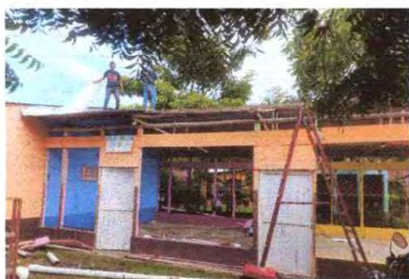
Foto 3: SUSTITUCION DE ESTRUCTURA DE METAL
