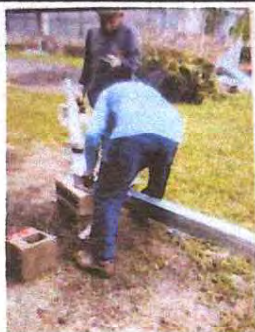
Foto1: SUSTITUCION DE ESTRUCTURA DE METAL
