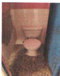
FOTO 11: SUSTITUCION DE SANITARIOS
