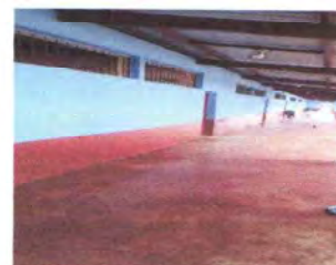
FOTO 8: PINTURA MURO INTERIOR Y EXTERIOR
