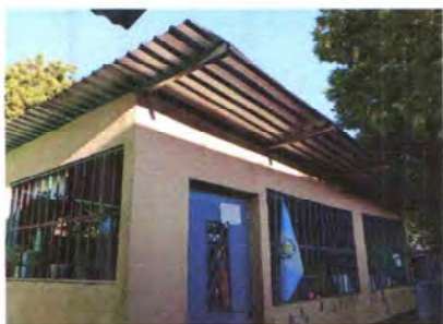
FOTO 1: SUSTITUCION DE LAMINA POR LAMINA TROQUEALDA CAL.26
