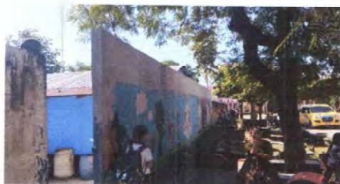
FOTO 13: REPARACION DE MURO PERIMETRAL
