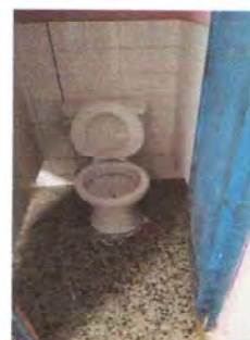
FOTO 10: SUSTITUCION DE SANITARIOS
