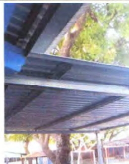
FOTO 2: SUSTITUCION DE LAMINA POR LAMINA TROQUEALDA CAL.26
