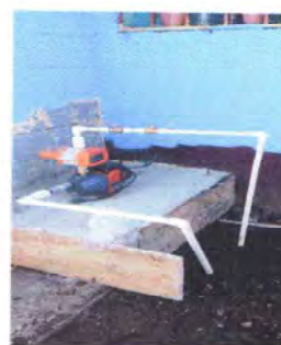
FOTO 18: SUSTITUCION E INSTALACION DE BOMBA DE AGUA
