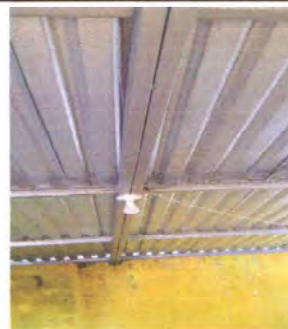
FOTO 4: MANTENIMIENTO DE ESTRUCTURA DE METAL
