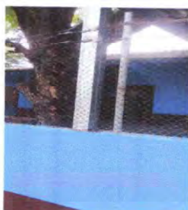
FOTO 15: MANTENIMIENTO DE MALLA
