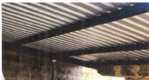
FOTO 3: SUSTITUCION DE ESTRUCTURA DE METAL
