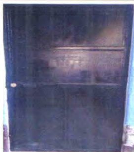
FOTO 5: SUSTITUCION DE PUERTAS DE MADERA POR PUERTAS DE METAL
