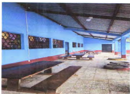
FOTO 9: PINTURA DE MURO INTERIOR Y EXTERIOR
