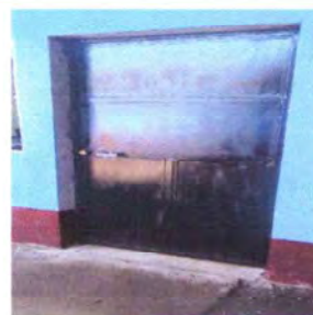
FOTO 6: SUSTITUCION DE PUERTAS DE MADERA POR PUERTAS DE METAL
