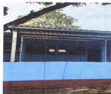
FOTO 16: MANTENIMIENTO DE MALLA
