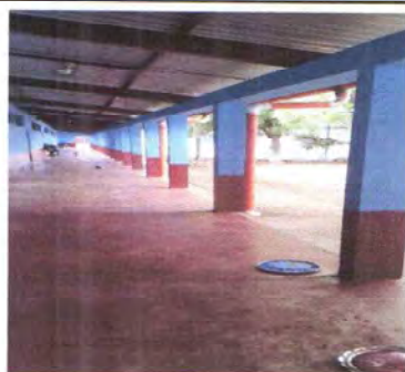
FOTO 7: PINTURA MURO INTERIOR Y EXTERIOR
