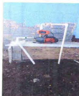
FOTO 17: SUSTITUCION E INSTALACION DE BOMBA DE AGUA
