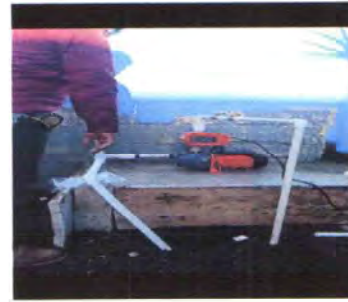
FOTO 16: SUSTITUCION E INSTALACION DE BOMBA DE AGUA
