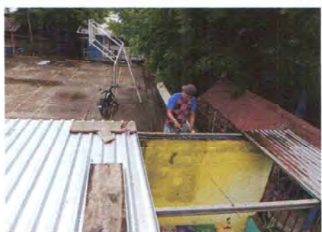
FOTO 3: MANTENIMIENTO DE ESTRUCTURA DE METAL
