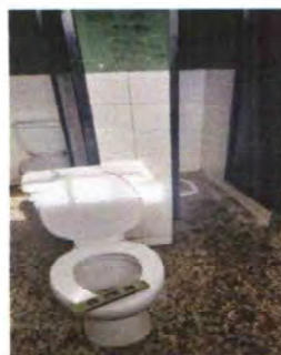
FOTO 10: SUSTITUCION DE SANITARIOS
