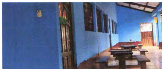
FOTO 8: PINTURA EN MURO EXTERIOR
