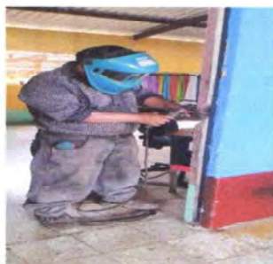
FOTO 5: SUSTITUCION DE PUERTAS DE MADERA POR PUERTAS DE METAL
