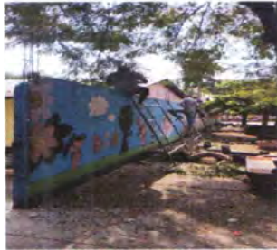
FOTO 13: REPARACION DE MURO PERIMETRAL DE BLOCK
