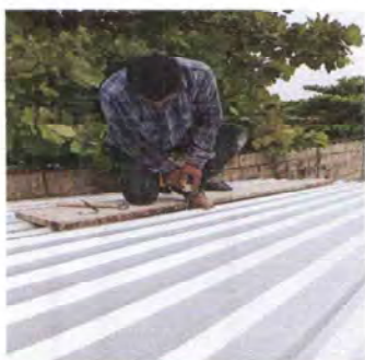
FOTO 1: SUSTITUCION DE LAMINA POR LAMINA TROQUELADA
