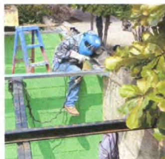
FOTO 2: SUSTITUCION DE ESTRUCTURA DE METAL
