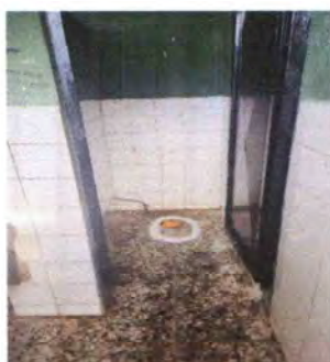
FOTO 9: SUSTITUCION DE SANITARIOS
