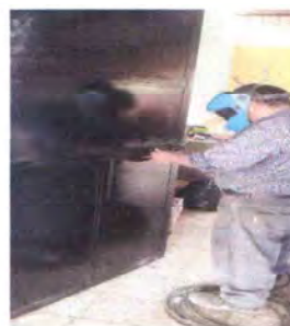
FOTO 6: SUSTITUCION DE PUERTAS DE MADERA POR PUERTAS DE METAL
