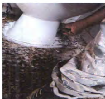
FOTO 11: SUSTITUCION DE SANITARIOS
