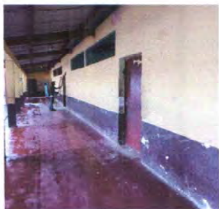
FOTO 7: PINTURA EN MURO EXTERIOR
