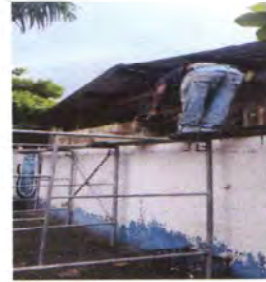
FOTO 14: REPARACION DE MURO PERIMETRAL DE BLOCK
