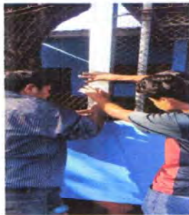
FOTO 15: MANTENIMIENTO DE MALLA
