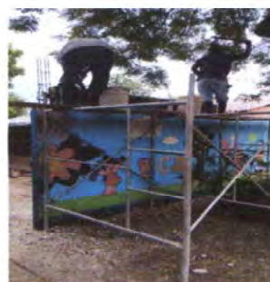
FOTO 12: REPARACION DE MURO PERIMETRAL DE BLOCK
