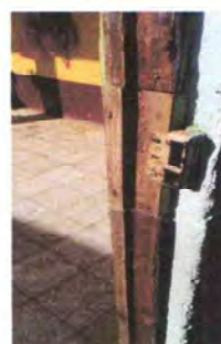
FOTO 4: SUSTITUCION DE PUERTAS DE MADERA POR PUERTAS DE METAL
