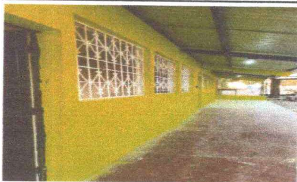
FOTO 3: Mantenimiento a estructura de metal de ventana
