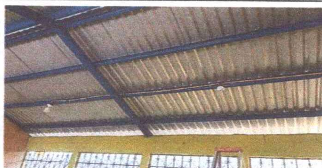
FOTO 6: Sustitución de ducto eléctrico mas accesorios
