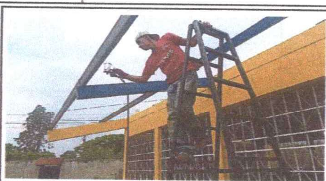
FOTO 2: ; Mantenimiento a estructura de soporte de metal
