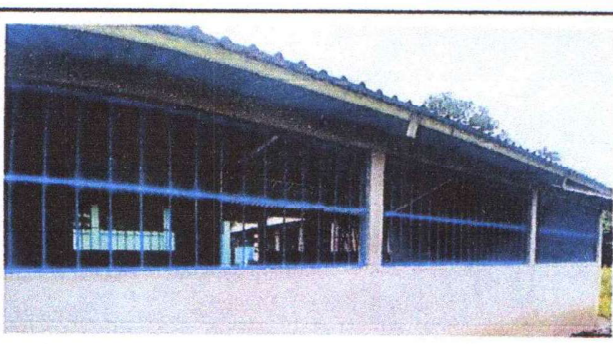
FOTO 4: INSTALACIÓN DE BALCONES
