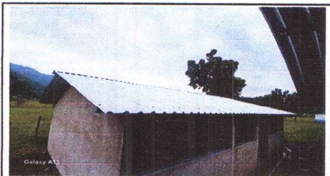
FOTO 3: INSTALACIÓN DE LAMINA TROQUELADA
