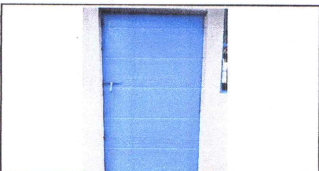
FOTO 5: SUSTITUCIÓN DE PUERTA DE METAL
