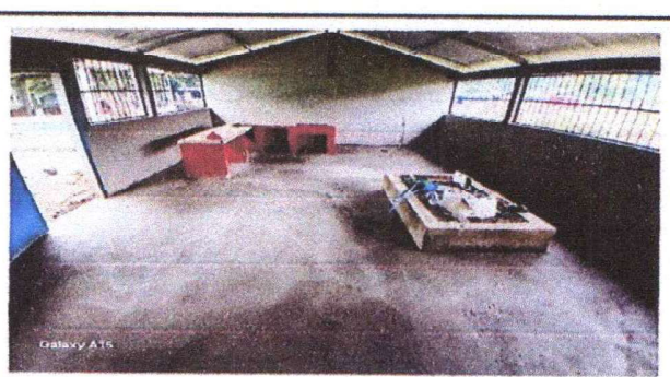
FOTO 6: SUSTITUCIÓN DE PISO DE TORTA
