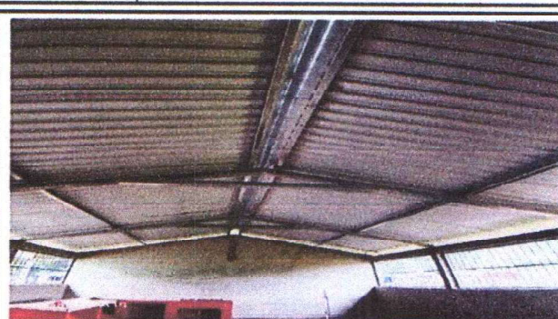
FOTO 2: INSTALACIÓN DE ESTRUCTURAS METÁLICAS
