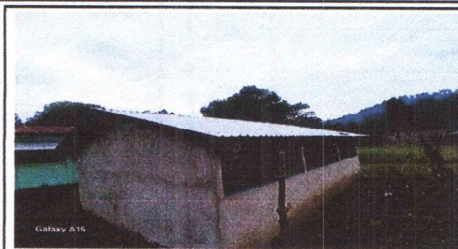
FOTO 1: LEVANTAMIENTO DE MURO
