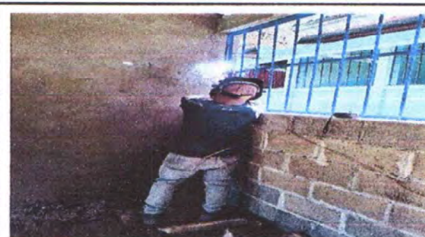
FOTO 4: FABRICACIÓN E INSTALACIÓN DE BALCONES
