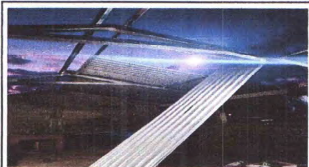
FOTO 3: INSTALACIÓN DE LAMINA TROQUELADA.
