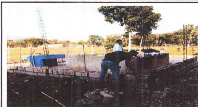
FOTO 1: LEVANTAMIENTO DE MURO
