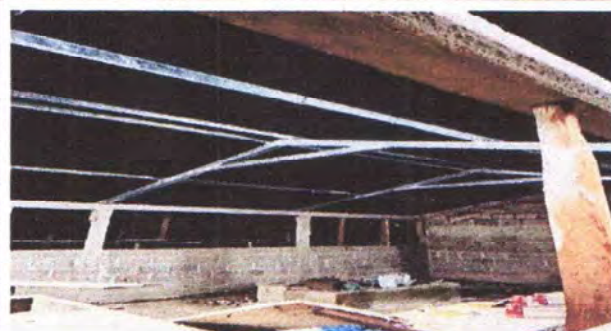
FOTO 2: INSTALACION DE ESTRUCTURAS METALICAS
