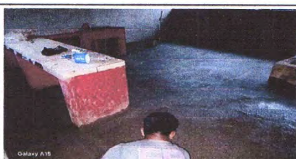
FOTO 6: SUSTITUCIÓN DE PISO DE TORTA
