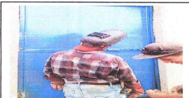
FOTO 5: SUSTITUCIÓN DE PUERTA DE METAL
