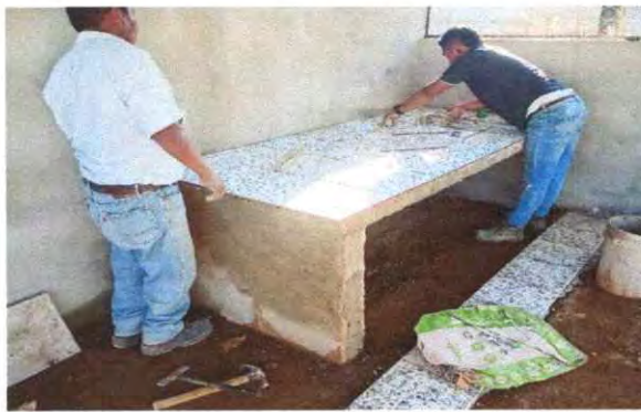
FOTO 16. REPARACION DE MESA DE CONCRETO
