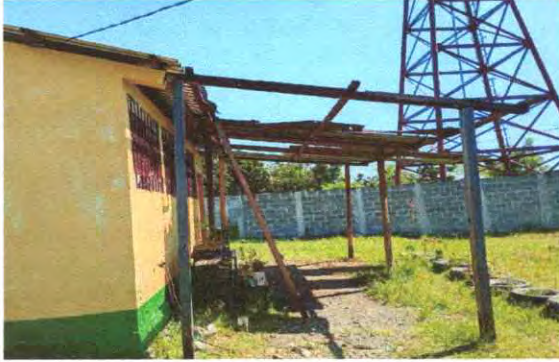
FOTO 1. SUSTITUCION DE LAMINAS POR LAMINA TROQUELADA CALIBRE 26.
