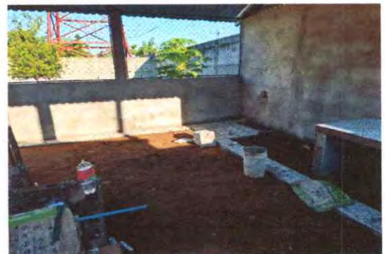
FOTO 6. SUSTITUCION DE PISO DE TORTA DE CONCRETO POR MISO GRANITO.
