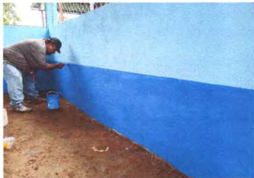
FOTO 7. PINTURA EN MUROS EXTERIORES E INTERIORES.
