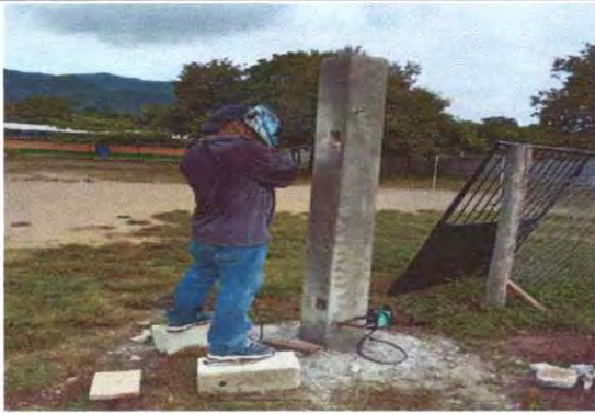
FOTO 3. SUSTITUCION DE PORTON 1, POR PORTON DE METAL.
