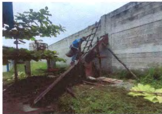
FOTO 8. REPARACION DE UNA COLUMNA DE MURO PERIMETRAL.
