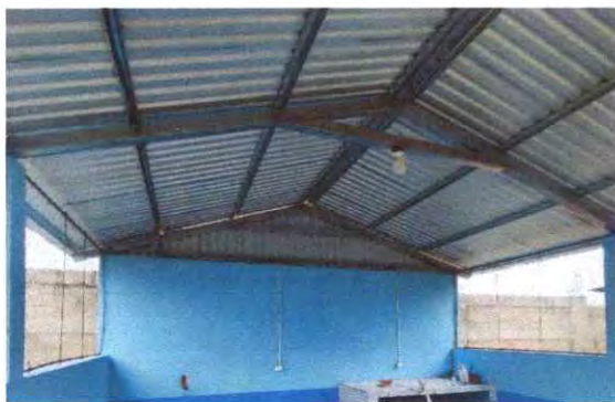
FOTO 9. SUSTITUCION DE PLAFOMERAS
