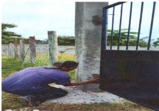
FOTO 3. SUSTITUCION DE PORTON 1, POR PORTON DE METAL.
