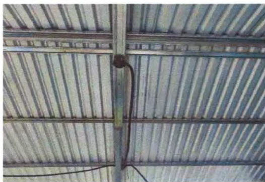
FOTO 9. SUSTITUCION DE PLAFOMERAS
