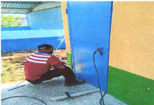
FOTO 5. SUSTITUCION DE PUERTA DE MADERA POR METAL.
