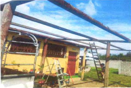
FOTO 1. SUSTITUCION DE LAMINAS POR LAMINA TROQUELADA CALIBRE 26.
