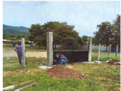
FOTO 4. SUSTITUCION DE PORTON 2, POR PORTON DE METAL.
