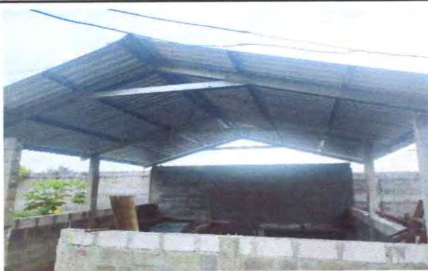
FOTO 13. SUSTITUCION DE ESTRUCTURA PORTANTE DE METAL
