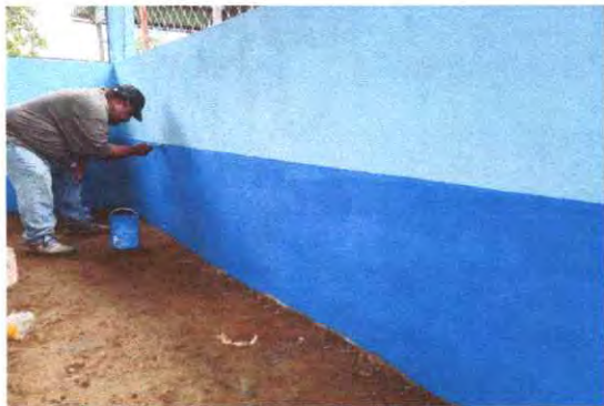
FOTO 7. PINTURA EN MUROS EXTERIORES E INTERIORES.
