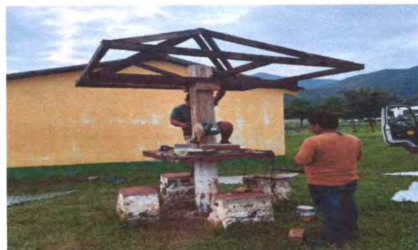
FOTO 17: SUSTITUCION DE LAMINAS, POR LAMINAS ALUZIN CALIBRE 26
