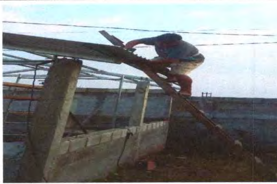
FOTO 14. INSTALACION DE LAMINAS TROQUELADA ALUZINC CALIBRE 26
