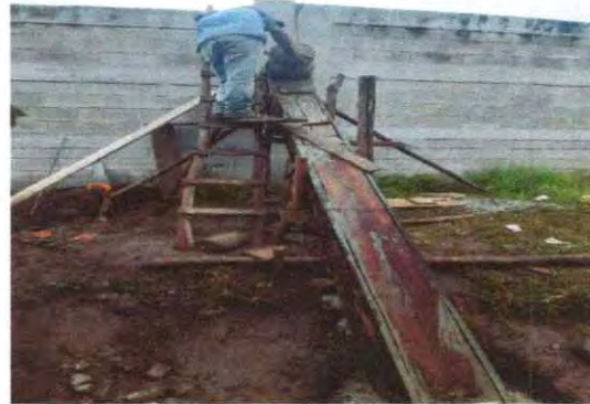
FOTO 8. REPARACION DE UNA COLUMNA DE MURO PERIMETRAL.
