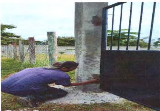
FOTO 3. SUSTITUCION DE PORTON 1, POR PORTON DE METAL.
