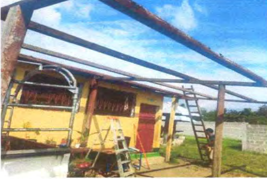
FOTO 1. SUSTITUCION DE LAMINAS POR LAMINA TROQUELADA CALIBRE 26.
