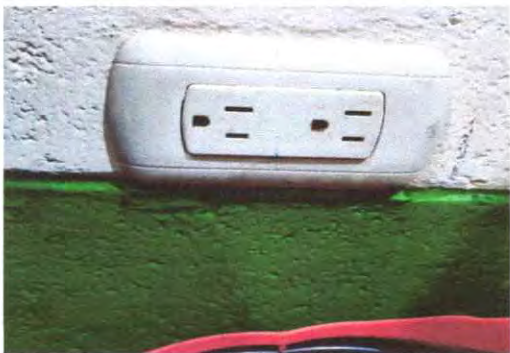
FOTO 11. SUSTITUCION DE TOMACORRIENTES DOBLES
