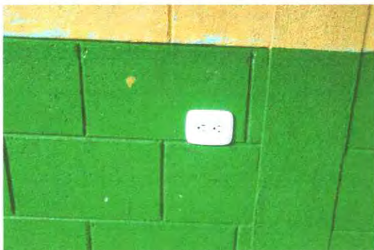
FOTO 11. SUSTITUCION DE TOMACORRIENTES DOBLES
