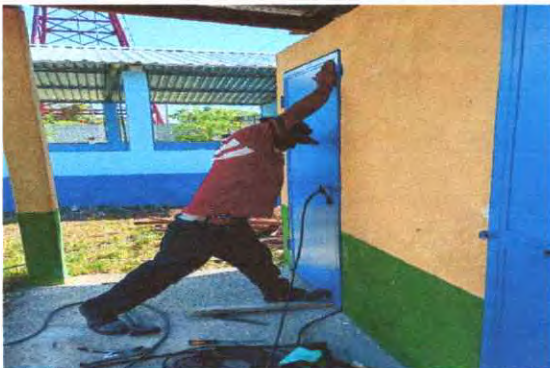
FOTO 5. SUSTITUCION DE PUERTA DE MADERA POR METAL.
