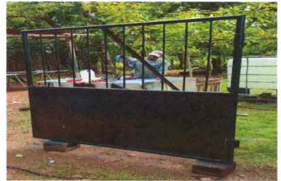
FOTO 4. SUSTITUCION DE PORTON 2, POR PORTON DE METAL.
