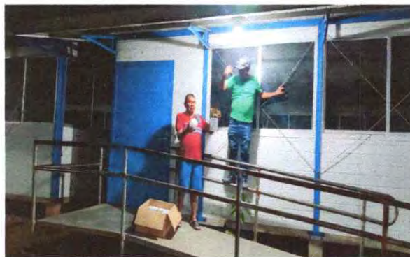
FOTO 10. SUSTITUCION DE FOCOS AHORRADORES
