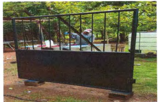
FOTO 4. SUSTITUCION DE PORTON 2, POR PORTON DE METAL.
