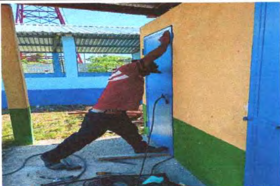
FOTO 5. SUSTITUCION DE PUERTA DE MADERA POR METAL.
