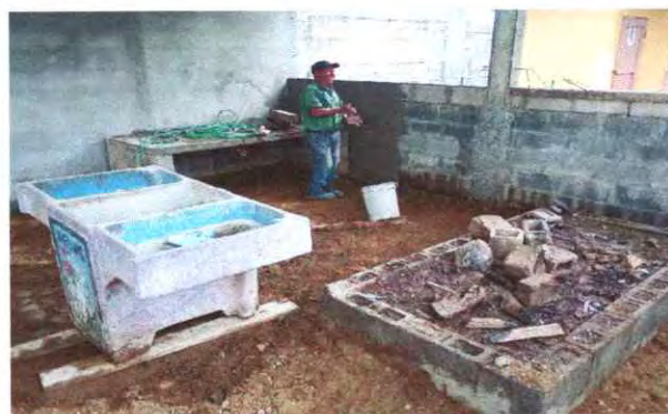
FOTO 15. MANTENIMIENTO DE ESTUFA RURAL
