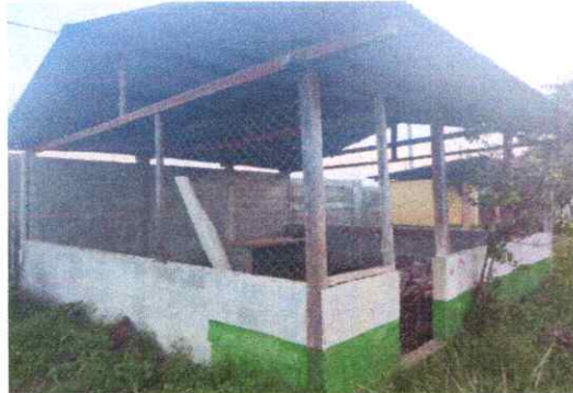
FOTO 2. SUSTITUCION DE ESTRUCTURA DE SOPORTE DE MADERA POR METAL.
