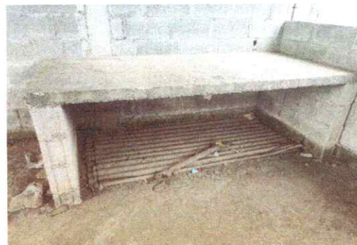
FOTO 16. REPARACION DE MESA DE CONCRETO
