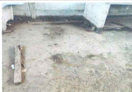
FOTO 6. SUSTITUCION DE PISO DE TORTA DE CONCRETO POR MISO GRANITO.
