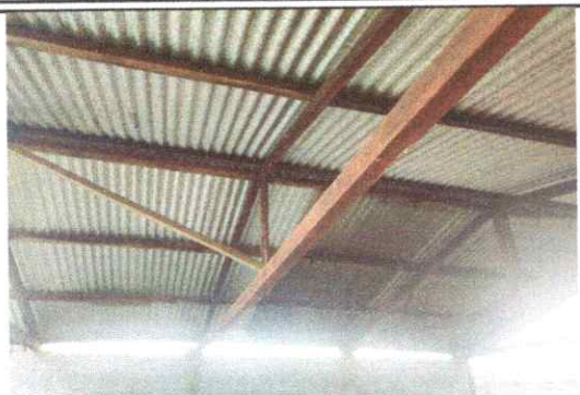
FOTO 13. SUSTITUCION DE ESTRUCTURA PORTANTE DE METAL
