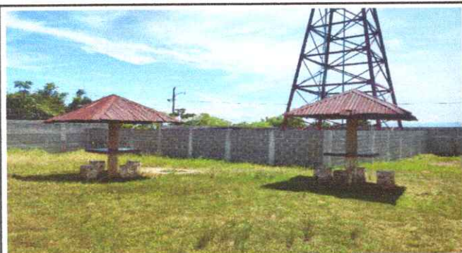
FOTO 17: SUSTITUCION DE LAMINAS, POR LAMINAS ALUZIN CALIBRE 26
