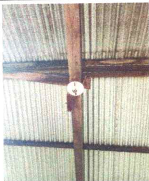
FOTO 9. SUSTITUCION DE PLAFOMERAS
