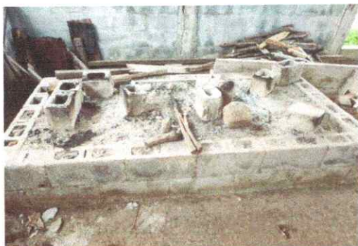
FOTO 15. MANTENIMIENTO DE ESTUFA RURAL
