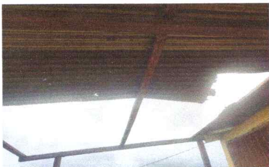
FOTO 1. SUSTITUCION DE LAMINAS POR LAMINA TROQUELADA CALIBRE 26.
