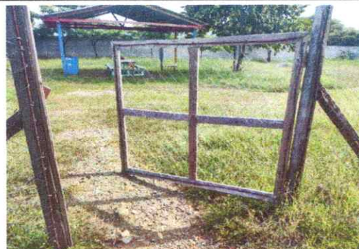
FOTO 4. SUSTITUCION DE PORTON 2, POR PORTON DE METAL.
