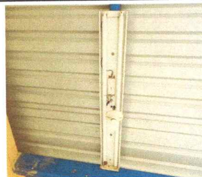
FOTO 10. SUSTITUCION DE FOCOS AHORADORAS
