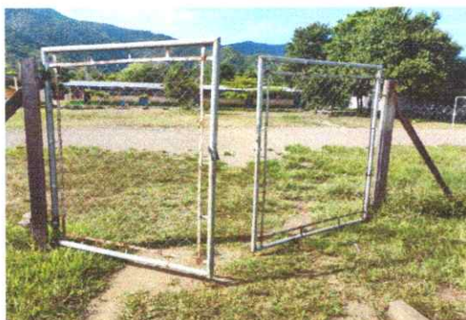
FOTO 3. SUSTITUCION DE PORTON 1, POR PORTON DE METAL.
