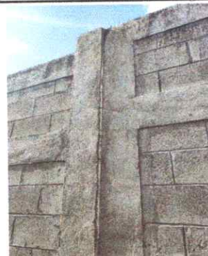
FOTO 8. REPARACION DE UNA COLUMNA DE MURO PERIMETRAL.
