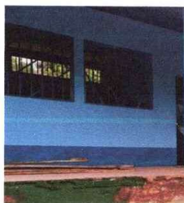
FOTO 5: MANTENIMIENTO DE BALCONES
