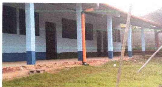
FOTO 6: PINTURA MUROS INTERIOR Y EXTERIOR
