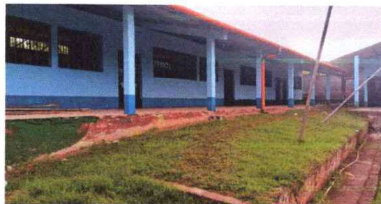
FOTO 7: PINTURA MUROS INTERIOR Y EXTERIOR
