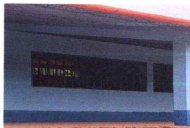
FOTO 4: MANTENIMIENTO DE BALCONES
