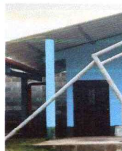
FOTO 10: MANTENIMIENTO DE PUERTAS
