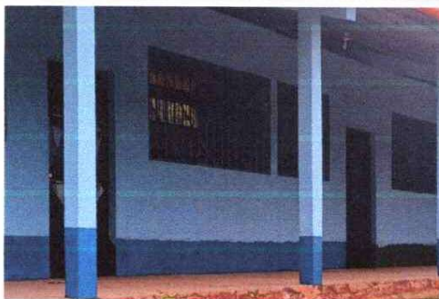
FOTO 9: MANTENIMIENTO DE PUERTAS
