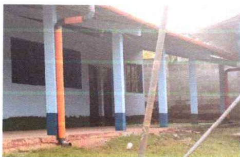
FOTO 3: INSTALACION DE CANALES PARA AGUA
