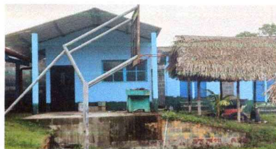
FOTO 8: PINTURA MUROS INTERIOR Y EXTERIOR
