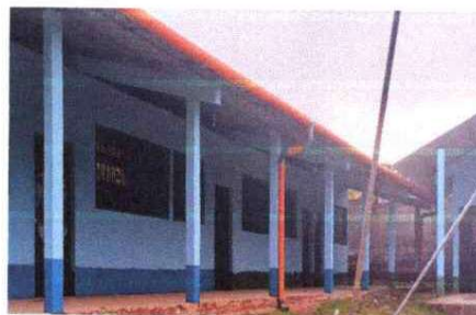
FOTO 2: INSTALACION DE CANALES PARA AGUA
