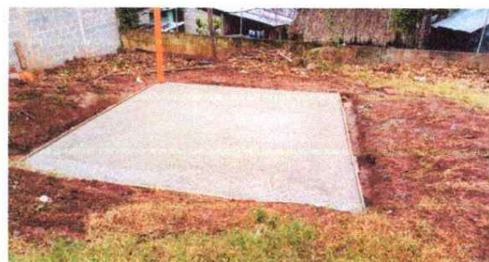
FOTO 12: INSTALACION DE FOSA SÉPTICA
