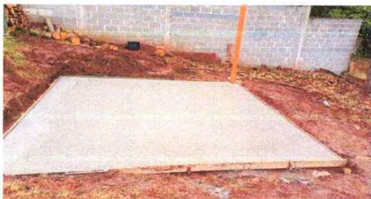
FOTO 11: INSTALACION DE FOSA SÉPTICA
