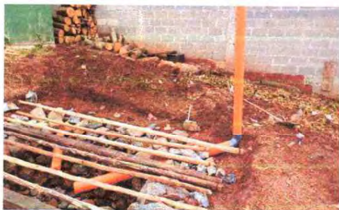
FOTO 17: INSTALACION DE FOSA SÉPTICA
