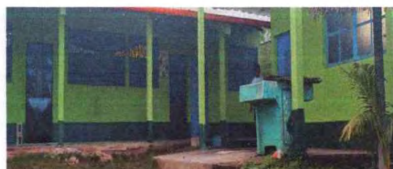
FOTO 12: MANTENIMIENTO DE PUERTAS
