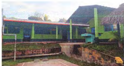
FOTO 9: PINTURA EN MUROS INTERIOR Y EXTERIOR
