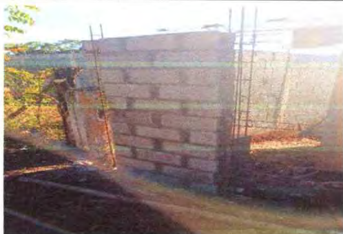
FOTO 3: LEVANTADO DE MURO PERIMETRAL
