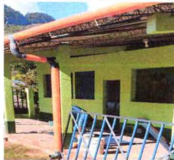
FOTO 6: INSTALACION DE CANALES PARA AGUA
