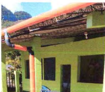
FOTO 5: INSTALACION DE CANALES PARA AGUA
