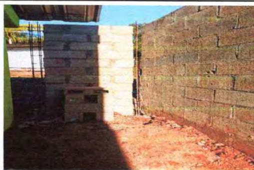
FOTO 4: LEVANTADO DE MURO PERIMETRAL
