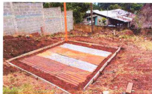
FOTO 18: INSTALACION DE FOSA SÉPTICA
