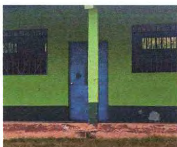
FOTO 11: MANTENIMIENTO DE PUERTAS
