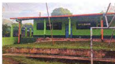
FOTO 8: PINTURA MUROS INTERIOR Y EXTERIOR
