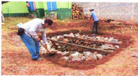
FOTO 15: INSTALACION DE FOSA SÉPTICA
