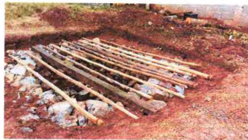
FOTO 16: INSTALACION DE FOSA SÉPTICA
