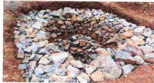
FOTO 14: INSTALACION DE FOSA SÉPTICA
