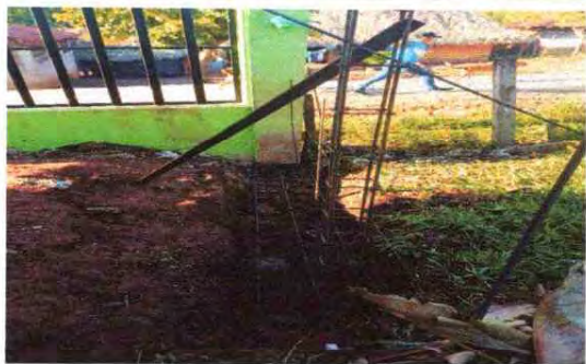
FOTO 1: REFUERZO PARA MURO PERIMETRAL
