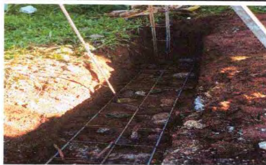
FOTO 2: REFUERZO PARA MURO PERIMETRAL
