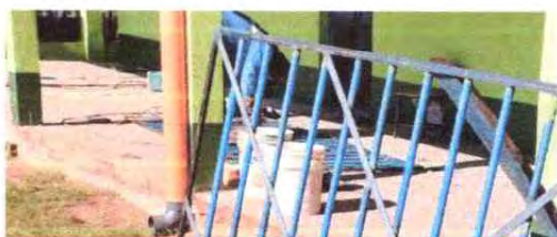
FOTO 7: MANTENIMIENTO DE BALCONES
