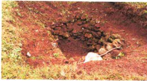
FOTO 13: INSTALACION DE FOSA SÉPTICA
