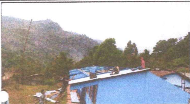
FOTO 1: INSTALACIÓN DE LAMINAS TROQUELADAS.
