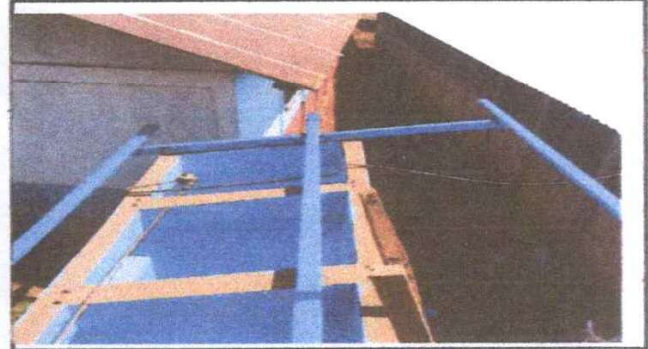
FOTO 4: CAMBIO DE ENTECHADO DEL SANITARIO
