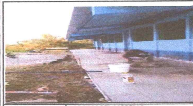
FOTO 5: REMODELACIÓN DE PISOS DEL CORREDOR.
