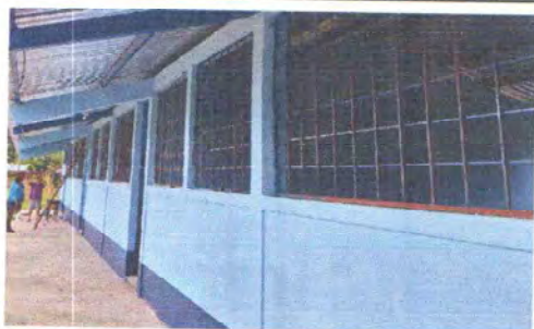
Foto 5: PINTURA EN MUROS EXTERIORES E INTERIORES
