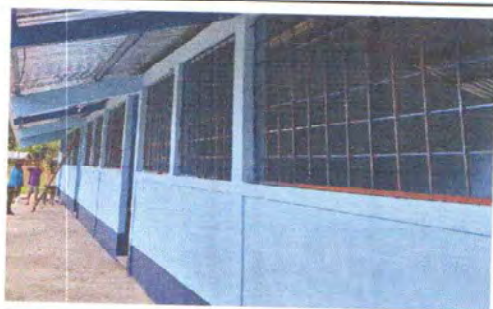
Foto 5: PINTURA EN MUROS EXTERIORES E INTERIORES
