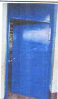
Foto 3: MANTENIMIENTO DE PUERTA
