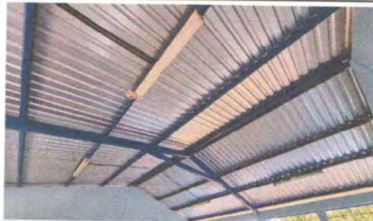
Foto 2: MANTENIMIENTO A ESTRUCTURA DE SOPORTE DE METAL
