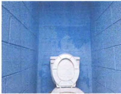
FOTO 7: SUSTITUCIÓN DE ACCESORIO INODORO
