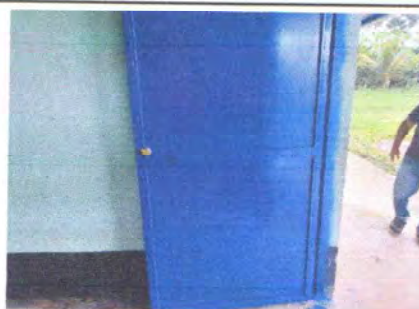
Foto 4: SUSTITUCIÓN DE CHAPAS
