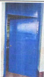
Foto 3: MANTENIMIENTO DE PUERTA
