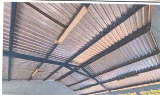
Foto 2: MANTENIMIENTO A ESTRUCTURA DE SOPORTE DE METAL
