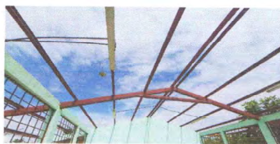
Foto 2: MANTENIMIENTO A ESTRUCTURA DE SOPORTE DE METAL
