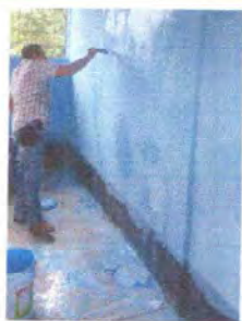
Foto 5: SPINTURA EN MUROS EXTERIORES E INTERIORES
