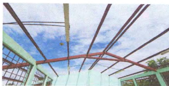
Foto 2: MANTENIMIENTO A ESTRUCTURA DE SOPORTE DE METAL
