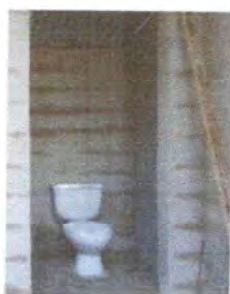
FOTO 7: SUSTITUCIÓN DE ACCESORIO INODORO
