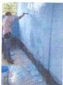
Foto 5: SPINTURA EN MUROS EXTERIORES E INTERIORES
