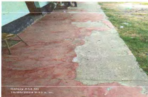
REPACIÓN DE PISO DE TORTA
