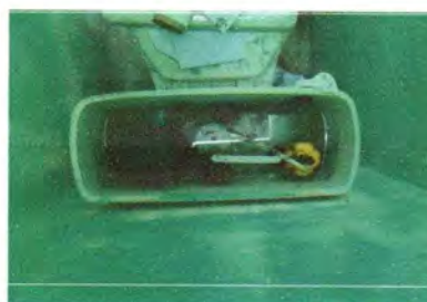
Foto 6: REPACIÓN DE BAÑOS
