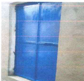
FOTO 5: SUSTITUCIÓN DE PUERTA DE METAL
