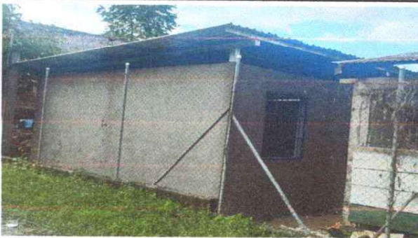
FOTO 3: INSTALACIÓN DE LAMINA TROQUELADA
