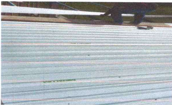
FOTO 3: INSTALACIÓN DE LAMINA TROQUELADA.
