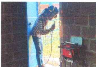
FOTO 5: SUSTITUCIÓN DE PUERTA DE METAL
