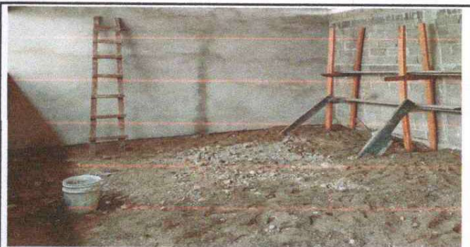
FOTO 6: SUSTITUCIÓN DE PISO DE TORTA
