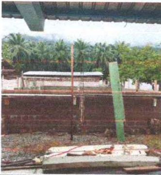
FOTO 1: LEVANTAMIENTO DE MURO
