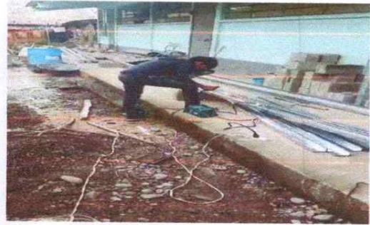
FOTO 2: INSTALACION DE ESTRUCTURAS METALICAS
