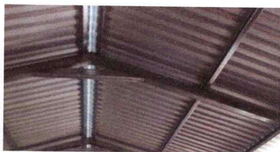
FOTO 4: SUSTITUCION DE ESTRUCTURA DE METAL
