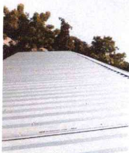
FOTO 1: SUSTITUCION DE LAMINA POR LAMINA TROQUEALDA CAL.26
