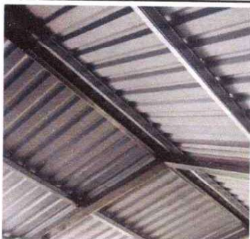
FOTO 3: SUSTITUCION DE ESTRUCTURA DE METAL
