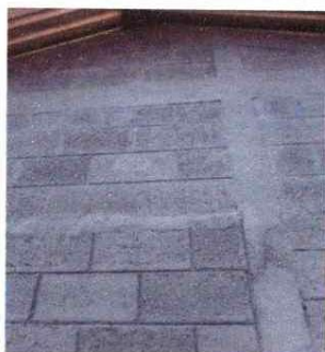
FOTO 6: REMODELACION Y LEVANTADO DE PAREDES.
