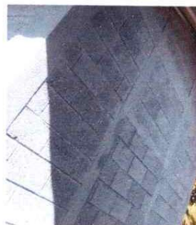
FOTO 7: REMODELACION Y LEVANTADO DE PAREDES.
