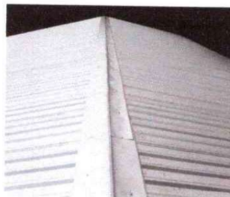
FOTO 2: SUSTITUCION DE LAMINA POR LAMINA TROQUEALDA CAL.26
