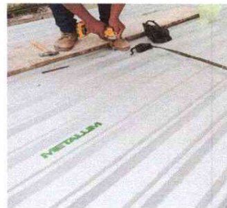
FOTO 2: SUSTITUCION DE LAMINA POR LAMINA TROQUELADA CAL.26
