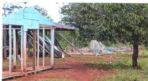
FOTO 6: REMODELACION Y LEVANTADO DE PAREDES.
