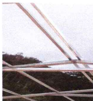
FOTO 4: SUSTITUCION DE ESTRUCTURA DE METAL
