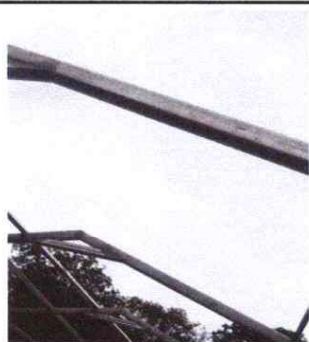
FOTO 3: SUSTITUCION DE ESTRUCTURA DE METAL
