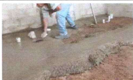
FOTO 5: SUSTITUCION DE PISO TORTA
