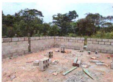
FOTO 8: REMODELACION Y LEVANTADO DE PAREDES.
