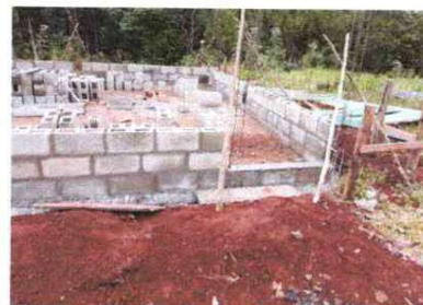
FOTO 7: REMODELACION Y LEVANTADO DE PAREDES.
