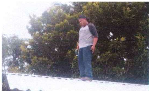
FOTO 1: SUSTITUCION DE LAMINA POR LAMINA TROQUELADA CAL.26
