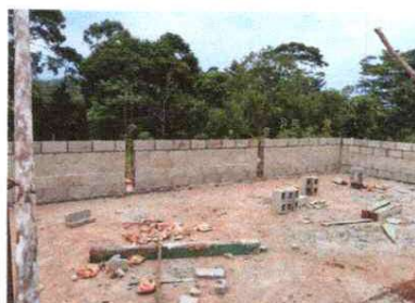
FOTO 9: REMODELACION Y LEVANTADO DE PAREDES.
