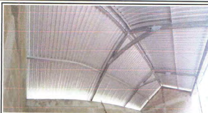
FOTO 2: INSTALACION DE ESTRUCTURAS METALICAS
