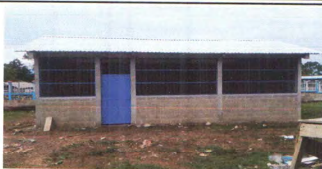
FOTO 1: INSTALACIÓN DE LAMINA TROQUELADA
