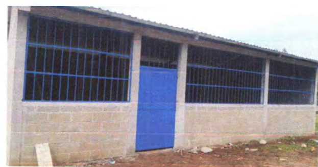
FOTO 3: INSTALACIÓN DE PUERTA DE METAL
