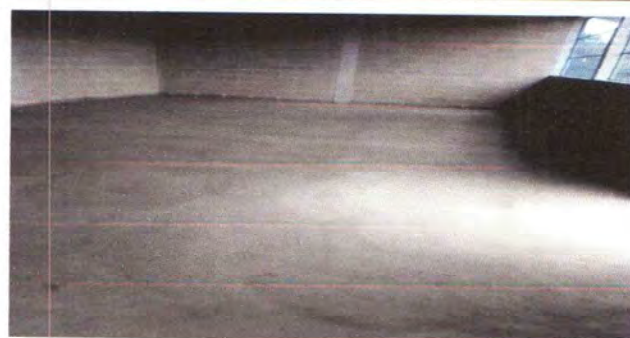
FOTO 4: SUSTITUCIÓN DE PISO DE TORTA
