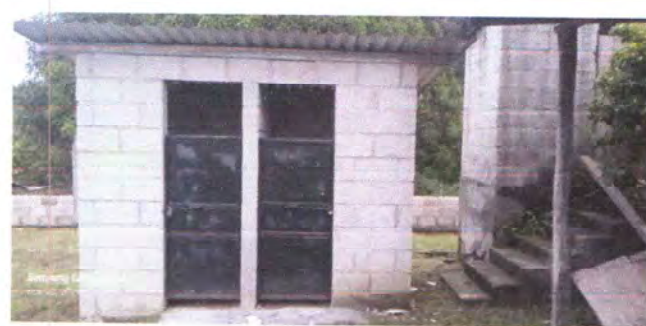
FOTO 6: INSTALACIÓN DE INODORO
