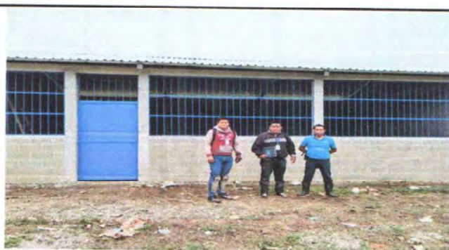
FOTO 5: SUSTITUCIÓN DE PUERTA DE METAL
