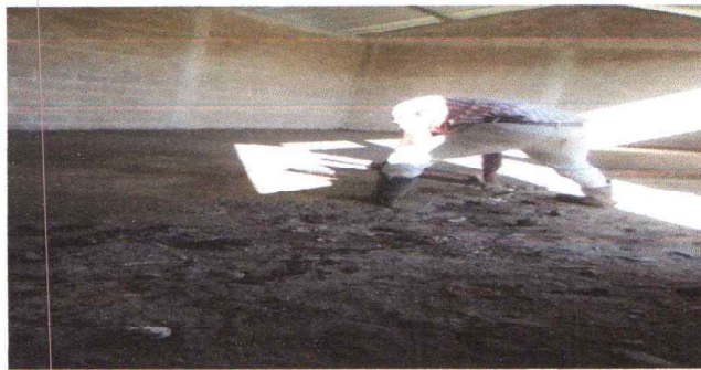
FOTO 4: SUSTITUCIÓN DE PISO DE TORTA
