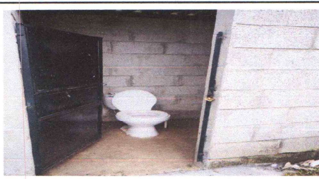
FOTO 6: INSTALACIÓN DE INODORO
