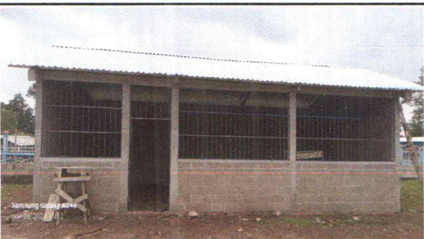
FOTO 4: FABRICACIÓN E INSTALACIÓN DE BALCONES
