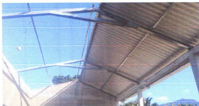
FOTO 1: INSTALACIÓN DE LAMINA TROQUELADA
