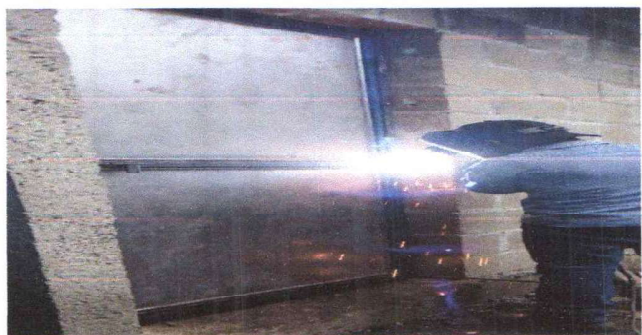
FOTO 3: INSTALACIÓN DE PUERTA DE METAL
