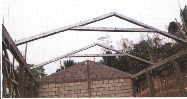
FOTO 2: INSTALACION DE ESTRUCTURAS METALICAS
