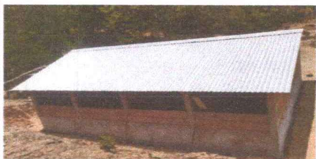
FOTO 5: SUSTITUCION DE LAMINADA TROQUELADA CALIBRE 26
