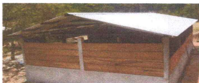
FOTO 6: SUSTITUCION DE LAMINA TROQUELADA CALIBRE 26
