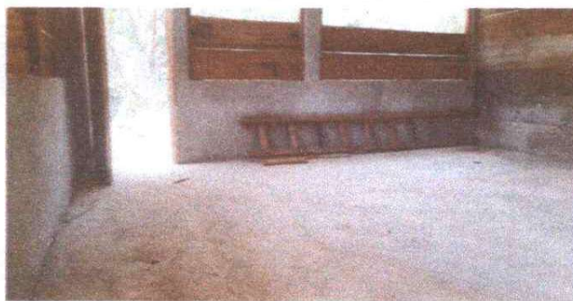
FOTO 2: REPARACION DE MURO EN AULAS
