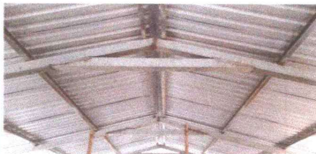
FOTO 4: SUSTITUCION DE ESTRUCTURA DE METAL
