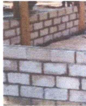
FOTO 2: REPARACION DE MURO EN AULAS
