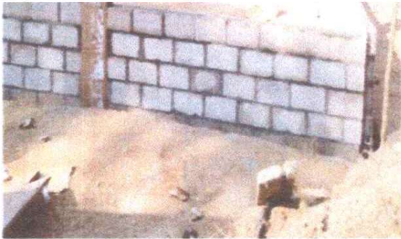
FOTO 1: REPARACION DE MURO DE AULAS
