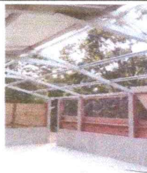
FOTO6: SUSTITUCION DE LAMINA TROQUELADA CAL. 26
