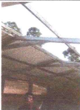
FOTO 5: SUSTITUCION DE ESTRUCTURA DE METAL
