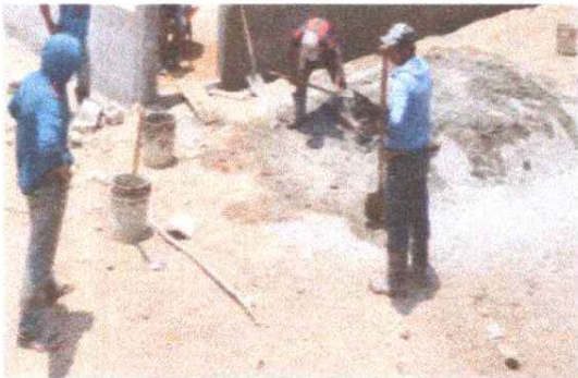
FOTO 3: REPARACION DE PISO TORTA
