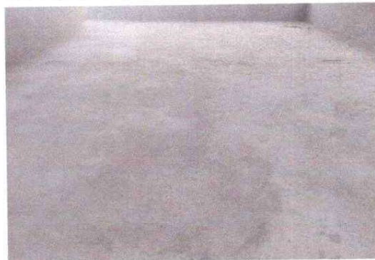
FOTO 4: REPARACION DE PISO TORTA
