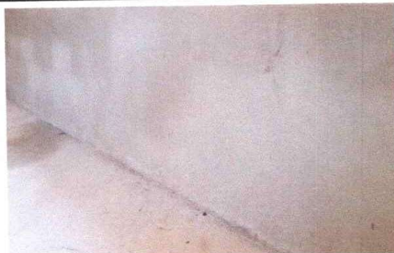
FOTO 2: REPARACION DE MURO EN AULAS
