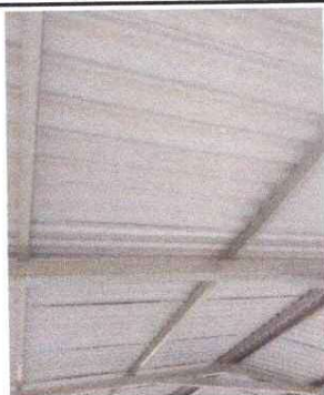
FOTO 5: SUSTITUCION DE ESTRUCTURA DE METAL
