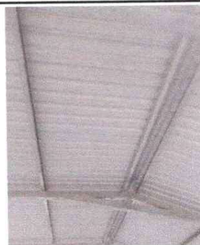
FOTO 6: SUSTITUCION DE LAMINA TROQUELADA CALIBRE 26
