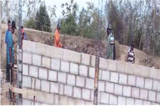
FOTO 1: REPARACION DE MURO DE AULAS
