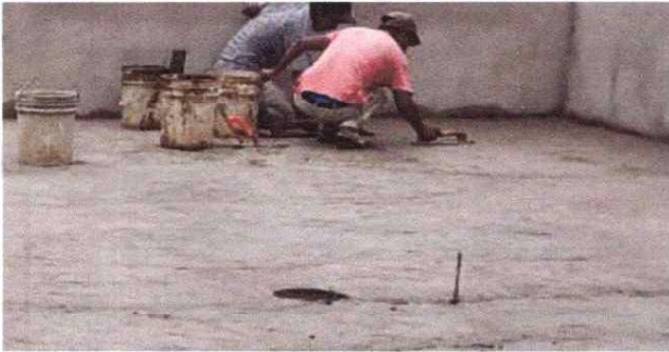
FOTO 3: REPARACION DE PISO TORTA
