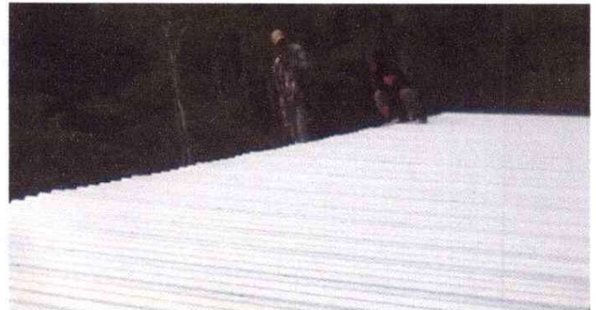
FOTO 6: SUSTITUCION DE LAMINA TROQUELADA CAL. 26
