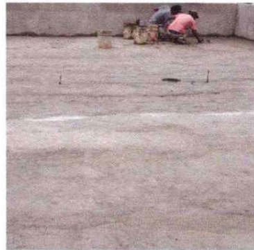
FOTO 4: REPARACION DE PISO TORTA
