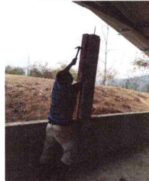
FOTO 2: REPARACION DE MURO EN AULAS
