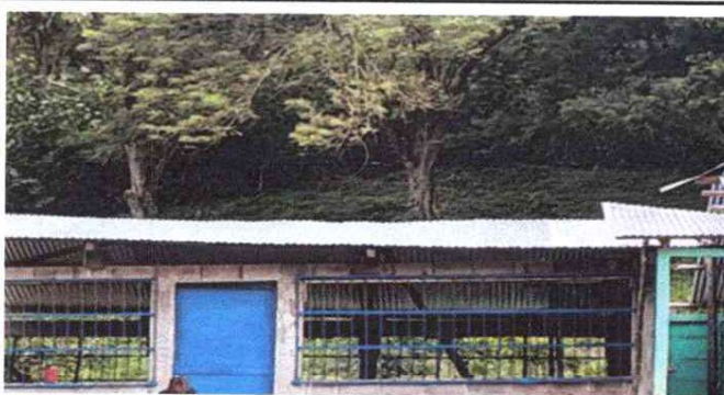
FOTO 3: SUSTITUCIÓN DE LÁMINA TROQUELADA.
