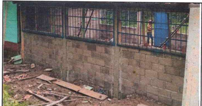
FOTO 4: INSTALACIÓN DE BALCONES DE METAL.
