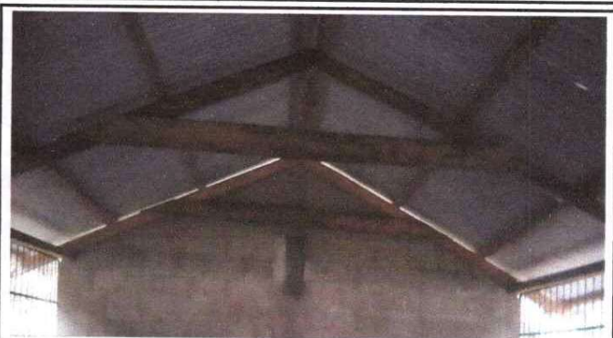
FOTO 2: SUSTITUCIÓN DE ESTRUCTURAS DE MADERA.
