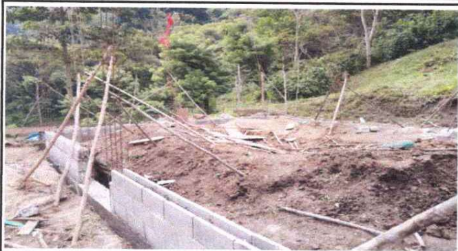
FOTO 1: LEVANTAMIENTO DE COLUMNA DE CONCRETO.
