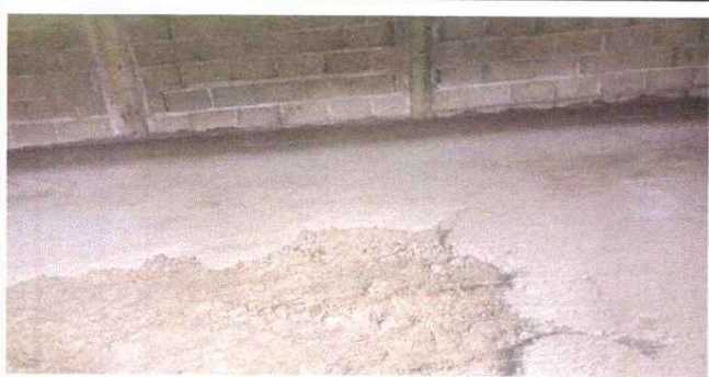
FOTO 5: SUSTITUCIÓN DE PISO DE CONCRETO.
