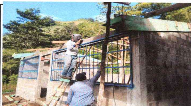
FOTO 4: INSTALACIÓN DE BALCONES DE METAL.
