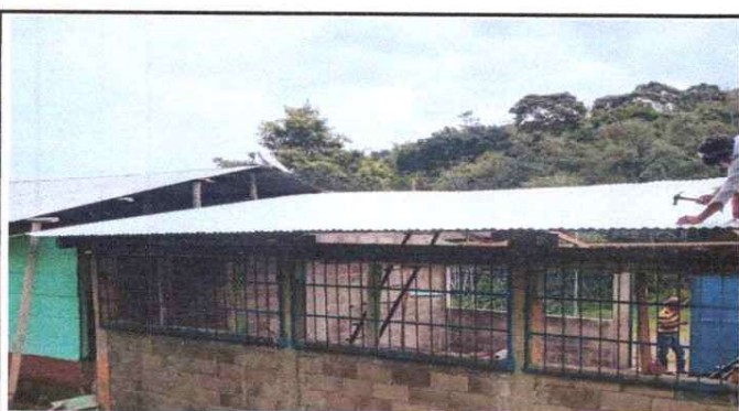
FOTO 3: SUSTITUCIÓN DE LAMINAS TROQUELADA.
