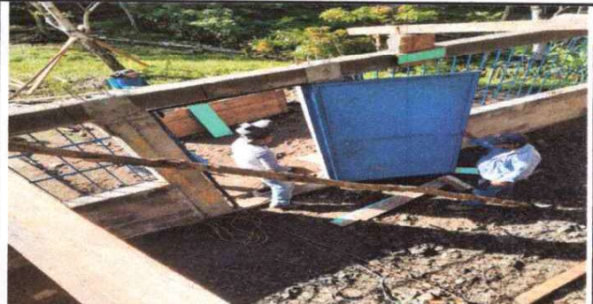
Foto 6: INSTALACIÓN DE PUERTA DE METAL.
