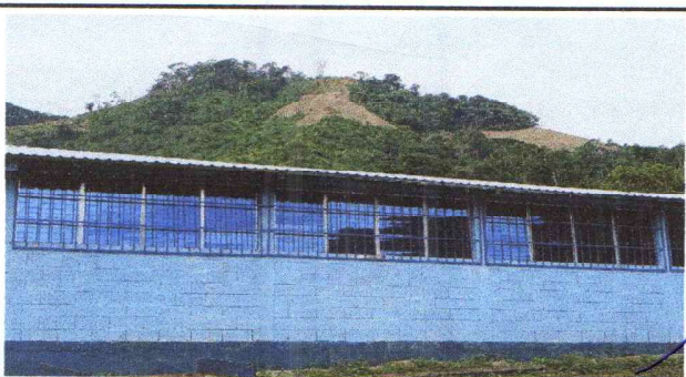
Foto 5: INSTALACIÓN DE VENTANAS DE VIDRIO.
