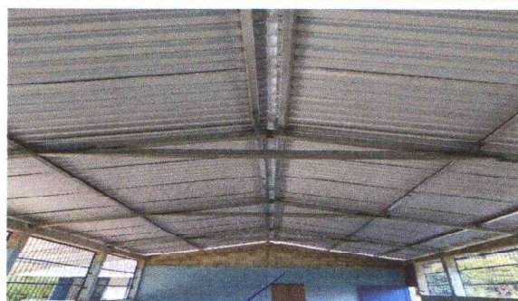
FOTO 2: SUSTITUCIÓN DE SOPORTE DE MADERA POR METAL.
