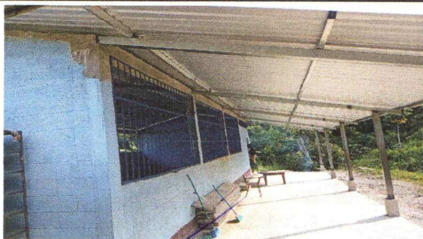
FOTO 4: SUSTICIÓN DE BALCONES DE METAL.
