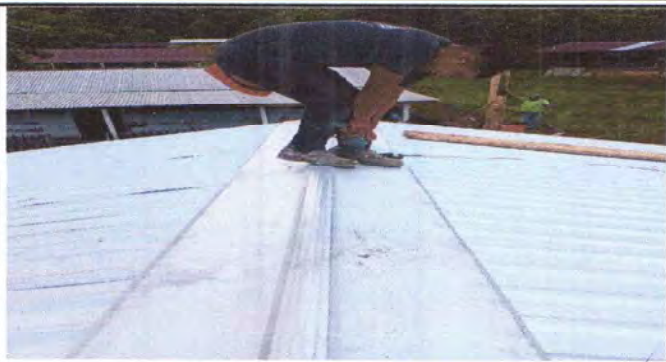
FOTO 1: SUSTITUCIÓN DE LAMINAS, POR LAMINAS TROQUELADAS C-26.
