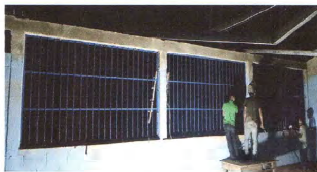
FOTO 4: SUSTITUCIÓN DE BALCONES DE METAL.
