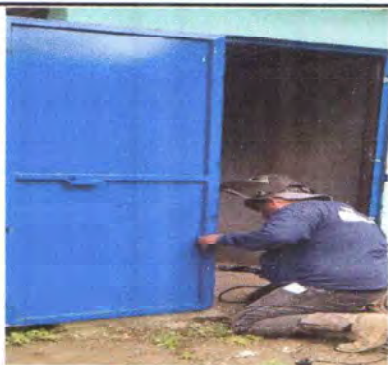
FOTO 3: SUSTITUCIÓN DE PUERTAS DE METAL.
