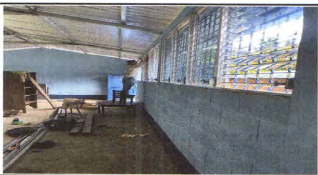
Foto 5: INSTALACIÓN DE VENTANAS DE VIDRIO .
