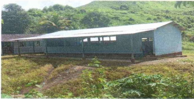
FOTO 1: SUSTITUCIÓN DE LAMINAS, POR LAMINAS TROQUELADAS C-26.
