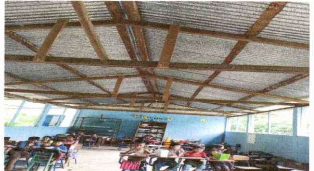
FOTO 2: SUSTITUCIÓN DE SOPORTE DE MADERA POR METAL.
