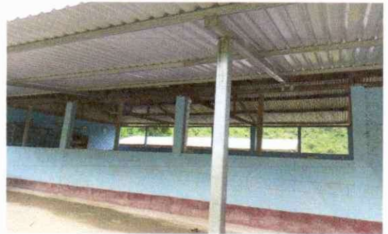
FOTO 4: SUSTICIÓN DE BALCONES DE METAL.
