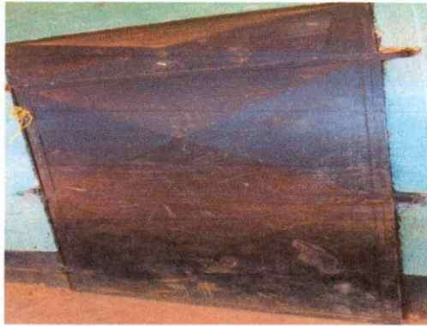
FOTO 3: SUSTITUCIÓN DE PUERTAS DE METAL.
