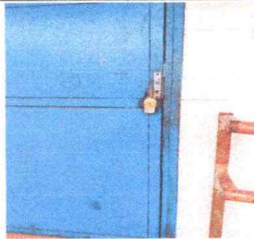
Foto 2: Chapaz colocadas y finalizadas.
