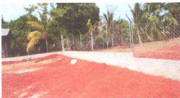
Foto 5: Finalización de muro perimetral
