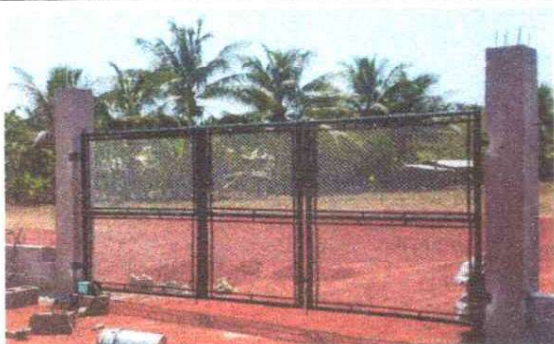
Foto 3: Finalización de colocación de portón
