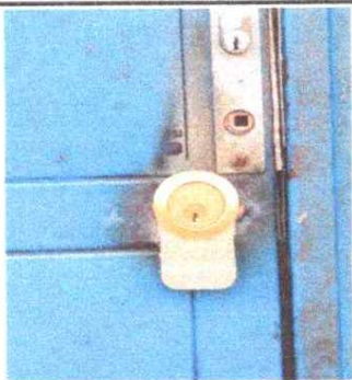
Foto 1: Chapaz colocadas y finalizadas.
