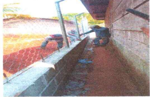
FOTO 2: Colocación de block con tubo hg y malla galvanizada, soleras intermedias y columnas para muro perimetral
