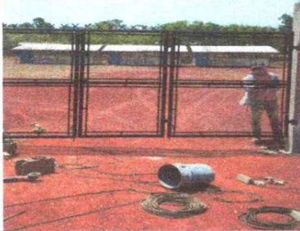
Foto 3: Armado y colocación de portón de metal
