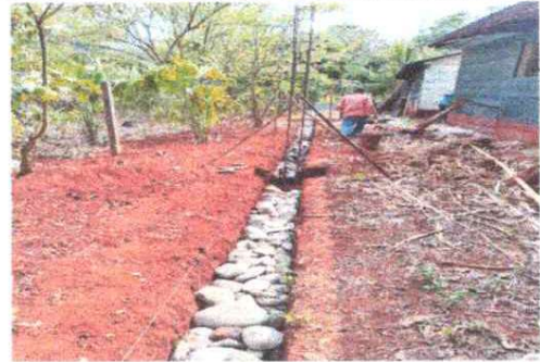
Foto 4: Zanjeado y colocación de piedras.
