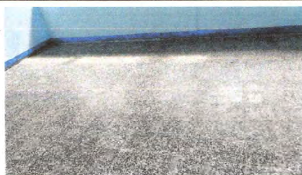
FOTO 10: SUSTITUCIÓN DE PISO DE GRANITO
