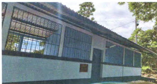
Foto 15: PINTURA EN MURO INTERIOR Y EXTERIOR.
