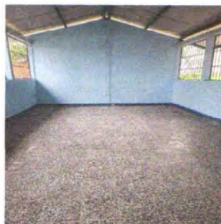
FOTO 14: PINTURA EN MURO INTERIOR Y EXTERIOR
