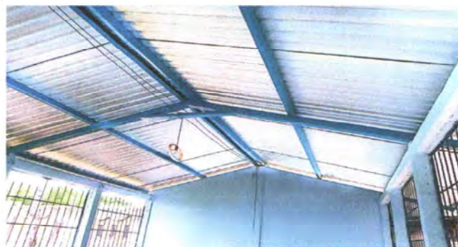
FOTO 2: SUSTITUCIÓN DE LAMINA POR LAMINA TROQUELADA CAL. 26
