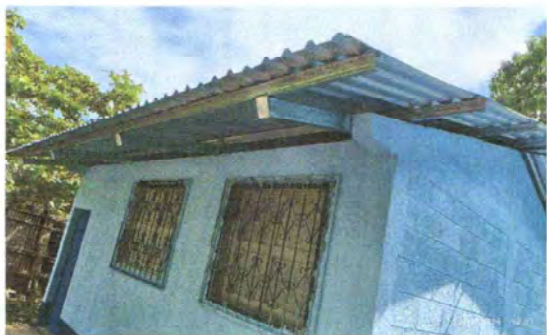
FOTO 3: SUSTITUCIÓN DE ESTRUCTURAS DE SOSPORTE DE MADERA POR METAL
