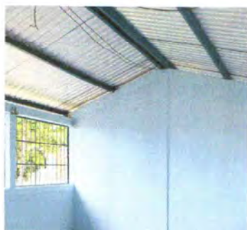
Foto 13: PINTURA EN MURO INTERIOR Y EXTERIOR.
