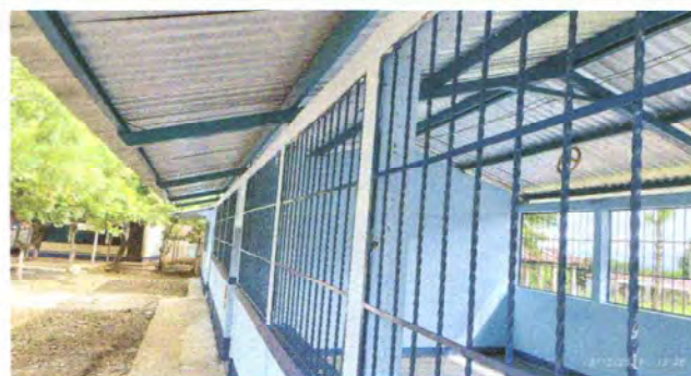
Foto 16: PINTURA EN MURO INTERIOR Y EXTERIOR.
