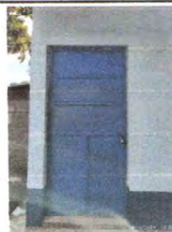
FOTO 12: MANTENIMIENTO DE PUERTA DE METAL
