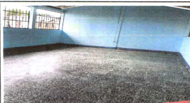
FOTO 9: SUSTITUCIÓN DE PISO DE GRANITO
