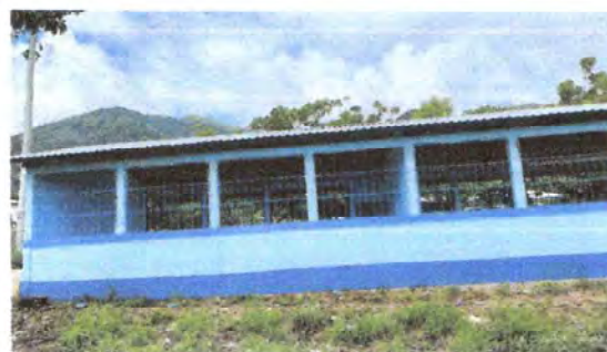
FOTO 8: SUSTITUCIÓN DE BALCONES DE METAL
