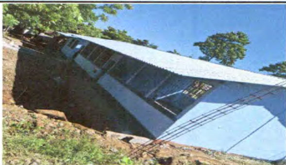
FOTO 1: SUSTITUCIÓN DE LAMINA POR LAMINA TROQUELADA CAL. 26
