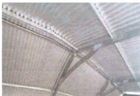
FOTO 4: SUSTITUCIÓN DE ESTRUCTURAS DE SOSPORTE DE MADERA POR METAL
