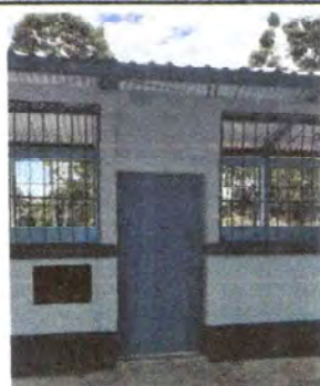
FOTO 11: MANTENIMIENTO DE PUERTA DE METAL
