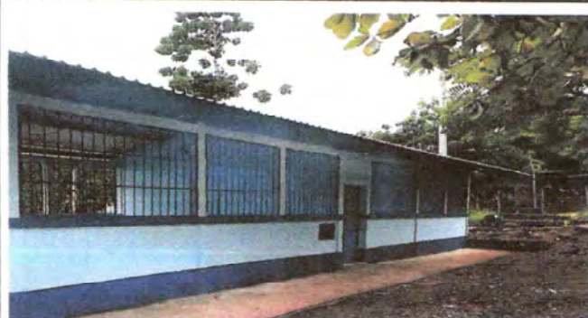
FOTO 7: SUSTITUCIÓN DE BALCONES DE METAL
