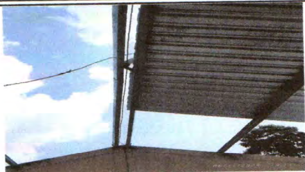
FOTO 1: SUSTITUCIÓN DE LAMINA POR LAMINA TROQUELADA CALI.- 26
