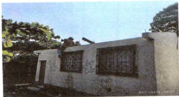
Foto 3: SUSTITUCIÓN DE ESTRUCTURAS DE SOPORTE DE MADERA POR METAL
