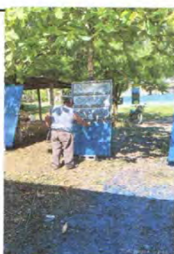
Foto 11: MANTENIMIENTO DE PUERTA DE METAL
