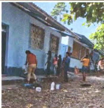
Foto 15: PINTURA EN MURO INTERIOR Y EXTERIOR.
