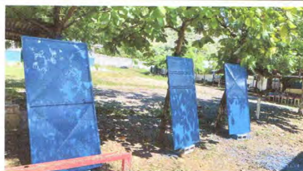
Foto 12: MANTENIMIENTO DE PUERTA DE METAL
