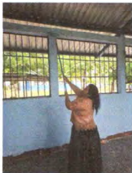
Foto 13: PINTURA EN MURO INTERIOR Y EXTERIOR.
