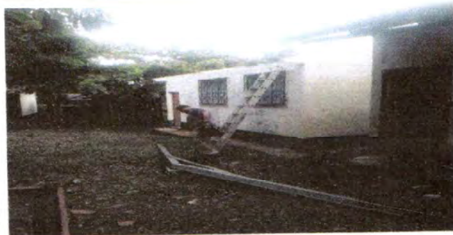
Foto 4: SUSTITUCIÓN DE ESTRUCTURAS DE SOPORTE DE MADERA POR METAL
