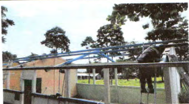
FOTO 5: MANTENIMIENTO A ESTRUCTURA DE SOPORTE DE METAL
