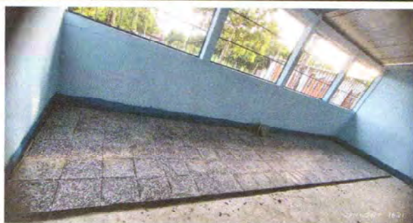
Foto 9: SUSTITUCIÓN DE PISO DE GRANITO
