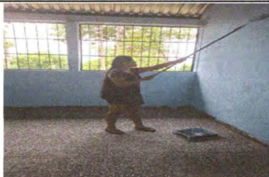
Foto 14: PINTURA EN MURO INTERIOR Y EXTERIOR.
