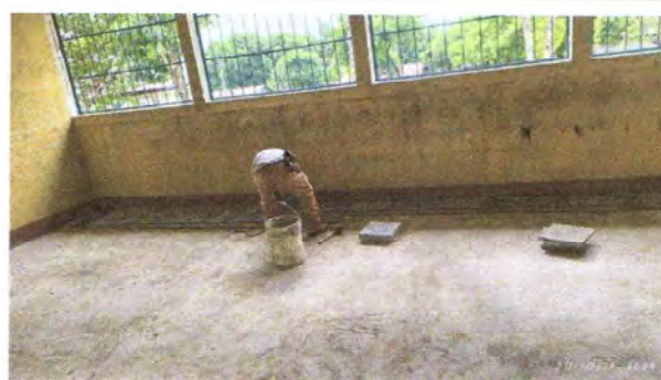
Foto 10: SUSTITUCIÓN DE PISO DE GRANITO
