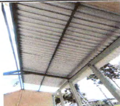
FOTO 2: SUSTITUCIÓN DE LAMINA POR LAMINA TROQUELADA CALI-26
