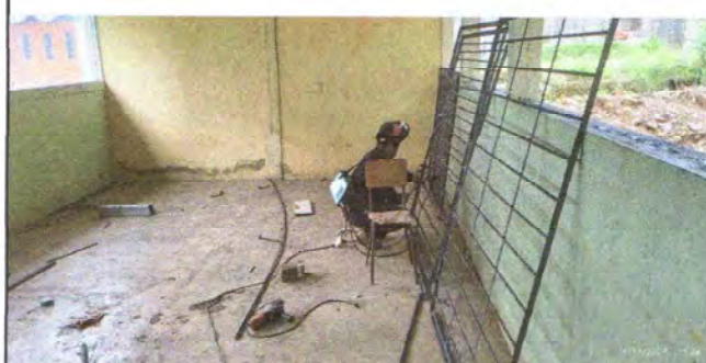
Foto 8: SUSTITUCIÓN DE BALCONES DE METAL
