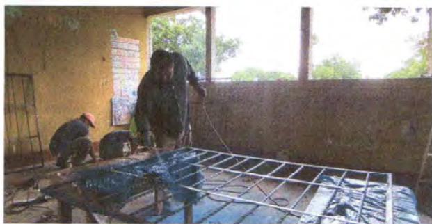
Foto 7: SUSTITUCIÓN DE BALCONES DE METAL
