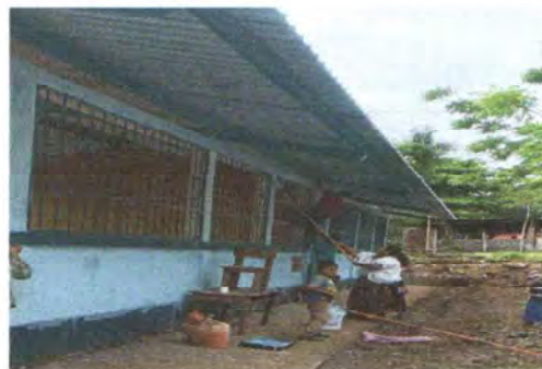
Foto 16: PINTURA EN MURO INTERIOR Y EXTERIOR.
