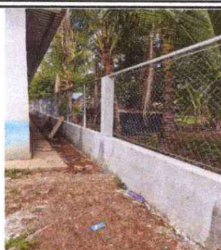
Foto 2: Reparacion de muro perimetral
