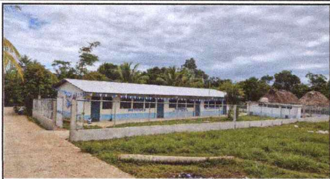
Foto1: Reparación de Muro Perimetral
