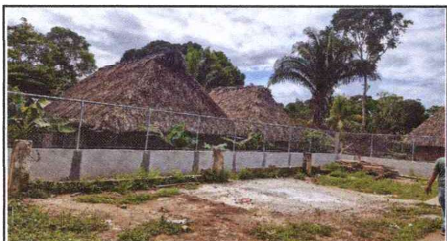
Foto 3: Reparación de Muro Perimetral
