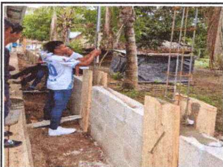
Foto 5: Reparación de muro perimetral
