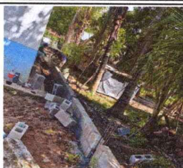
Foto 2: Reparación de muro perimetral
