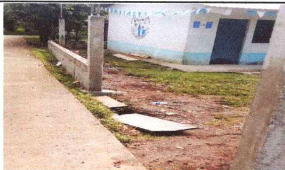
Foto1: Reparación de Muro Perimetral
