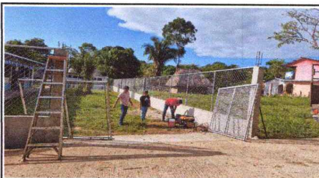
Foto 4: Fabricación e instalación de portón de metal de ingreso.
