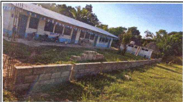
Foto 3: Reparación de muro perimetral
