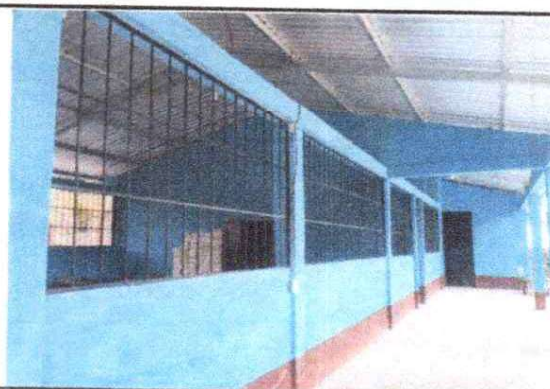
FOTO 4: Pintura en muros exteriores e interiores
