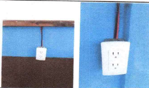
FOTO 8: Sustitucion tomacorrientes dobles
