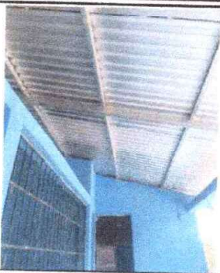
FOTO 1: Sustitución de estructura de soporte de madera, por metal
