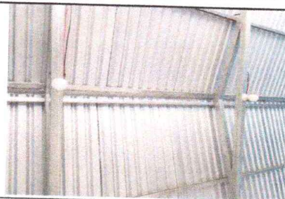
FOTO 8: Sustitucion de focos ahorradores
