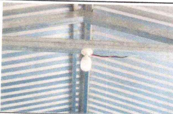
FOTO 8: Sustitucion de plafoneras
