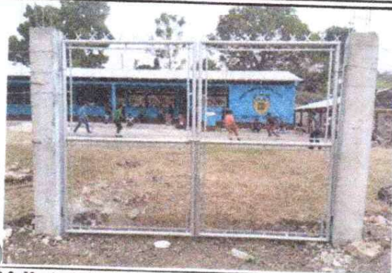
FOTO 6: Mantenimiento a portone de metal
