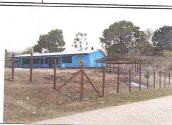
FOTO 7: Reparación de cerco
