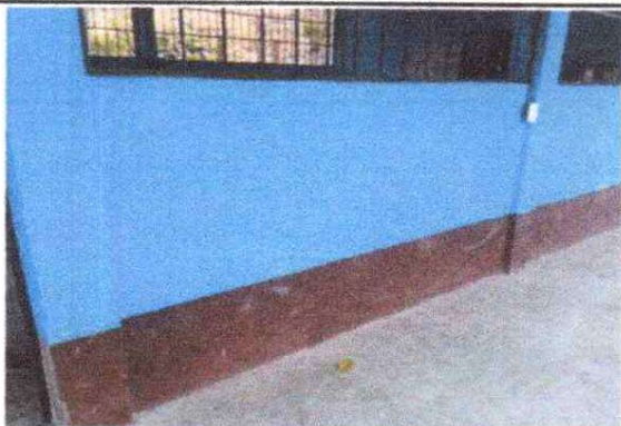
FOTO 9: Repello en Muro de pared
