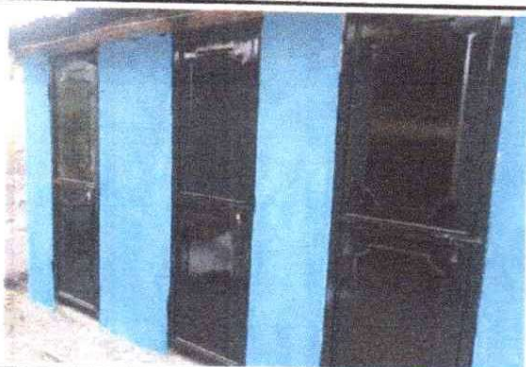
FOTO 5: Mantenimiento a estructura (lijado, cambio d tubo, cepillado, sujeciones, aplicación de pintura a puertas servicios sanitarios)
