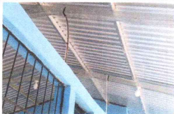
FOTO 8: Reparación de Cableado Electrico
