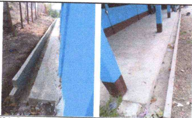
FOTO 3: Cuneta de Concreto
