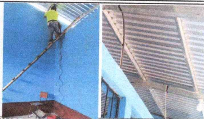
FOTO 8: Reparacion de Cableado Electrico
