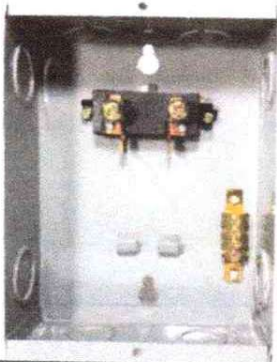
FOTO 8: Sustitucion de filpones
