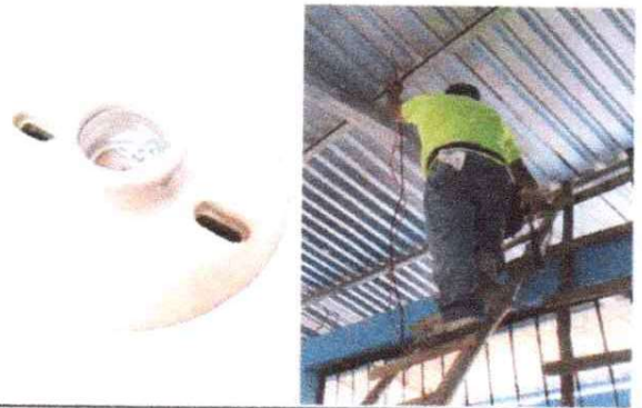
FOTO 8: Sustitucion de plafoneras
