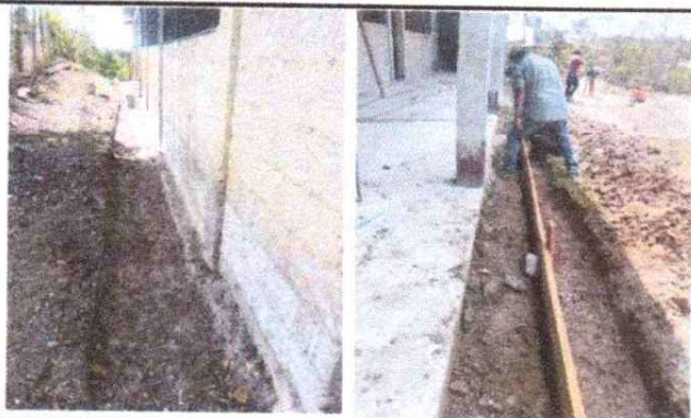
FOTO 3: Cuneta de Concreto
