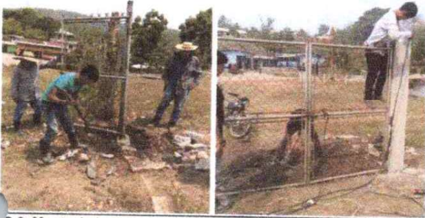
FOTO 6: Mantenimiento a portone de metal
