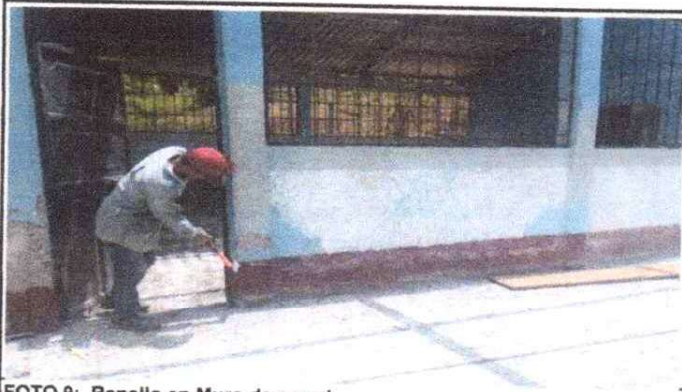
FOTO 9: Repello en Muro de pared
