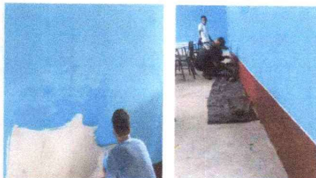
FOTO 4: Pintura en muros exteriores e interiores
