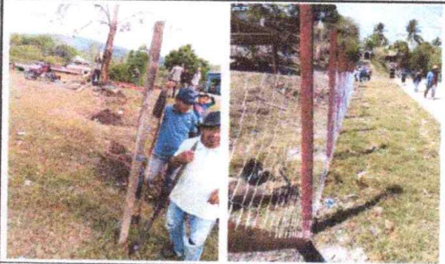
FOTO 7: Reparación de cerco
