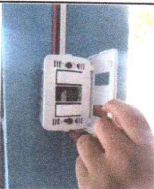
FOTO 8: Sustitucion interruptores simples
