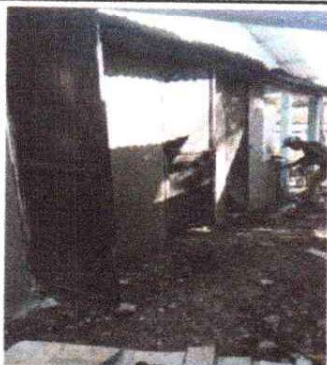
FOTO 5: Mantenimiento a estructura (lijado, cambio d tubo, cepillado, sujeciones, aplicación de pintura a puertas servicios sanitarios)
