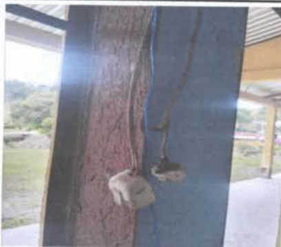
FOTO 8: Sustitucion interruptores simples
