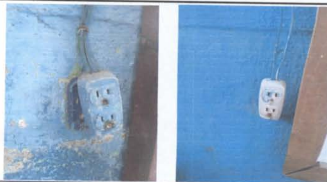
FOTO 8: Sustitucion tomacorrientes dobles
