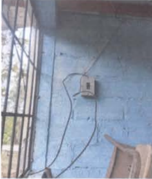
FOTO 8: Sustrucion de filpones
