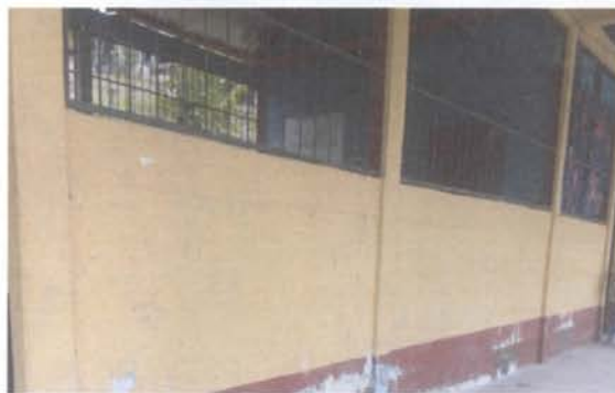
FOTO 4: Pintura en muros exteriores e interiores
