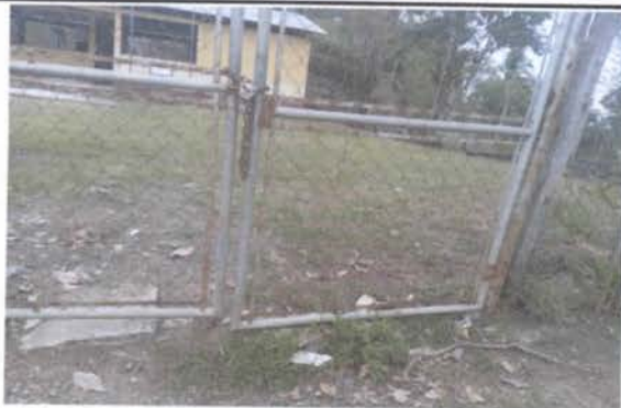
FOTO 6: Mantenimiento a portone de metal
