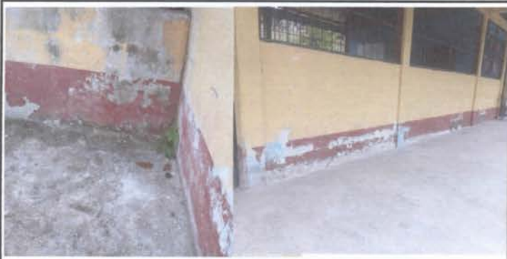
FOTO 9: Repello en Muro de pared
