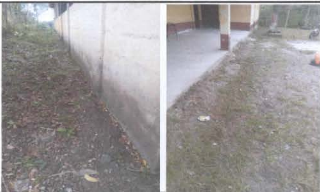
FOTO 3: Cuneta de Concreto
