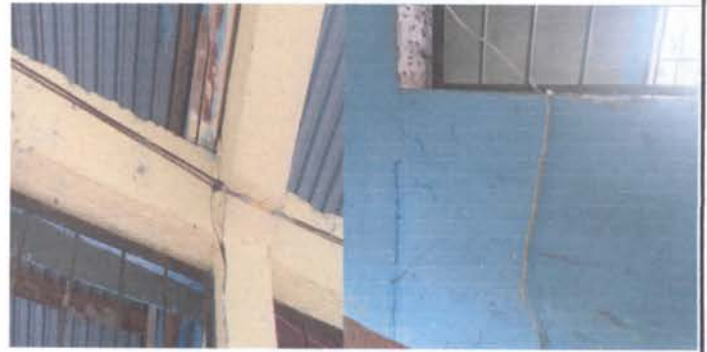
FOTO 8: Reparacion de Cableado Electrico
