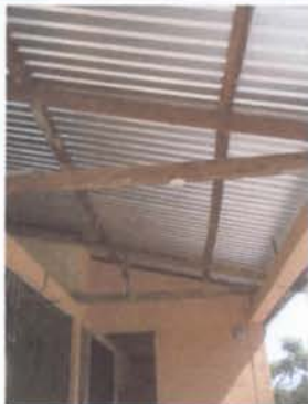
FOTO 1: Sustrucción de estructura de soporte de madera, por metal
