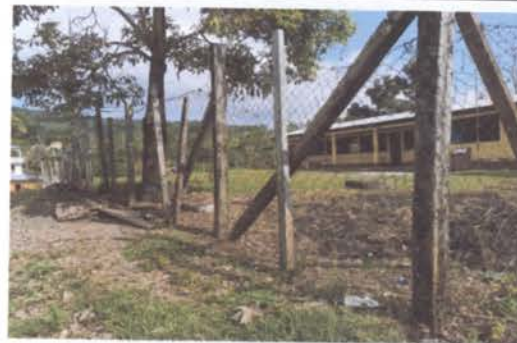
FOTO 7: Reparación de cerco
